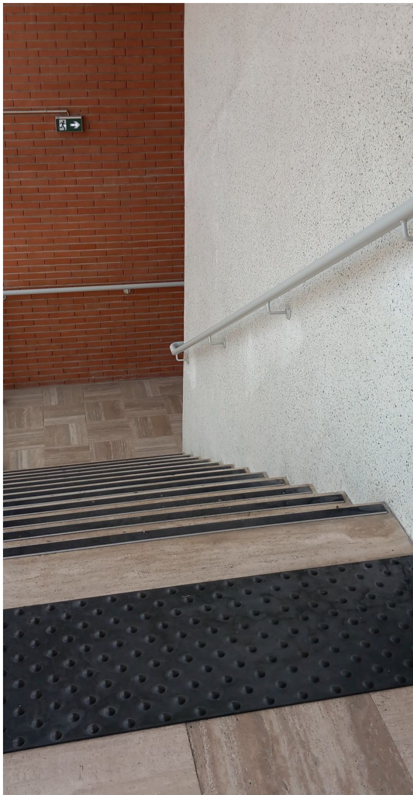
Escalier avec rampe et bande de guidage podotactile (Vue du 3 e étage)
