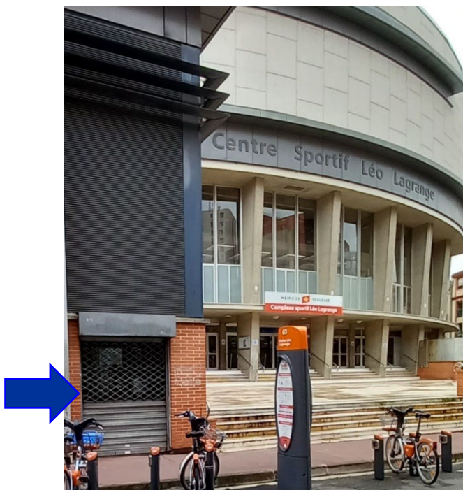
Interphone PMR extérieur (à l'angle de la place Riquet et de la rue des 7 troubadours)
