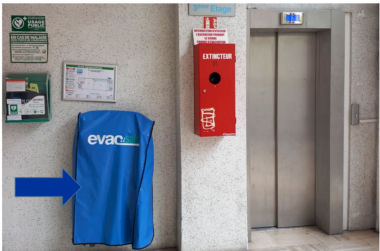
Chaise d'évacuation aux 3 e et 6 e étages du bâtiment C (à côté de l'ascenseur PMR et en face de l'escalier)
