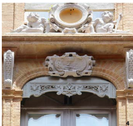
1. Immeuble rue Lafayette construit par Auguste Virebent en 1847, sculptures d'Antoine-Joseph Salamon, le Printemps et l'Été
