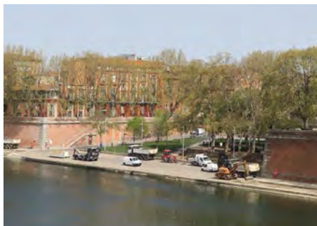
Port de la Daurade lors des travaux de réfection des quais (2021)
