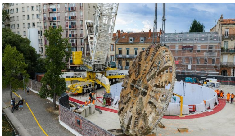
Sortie de la roue de coupe du tunnelier sur le puits Saint Sauveur
