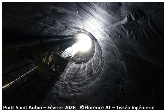
Puits Saint Aubin – Février 2026 - ©Florence AT – Tisséo Ingénierie
