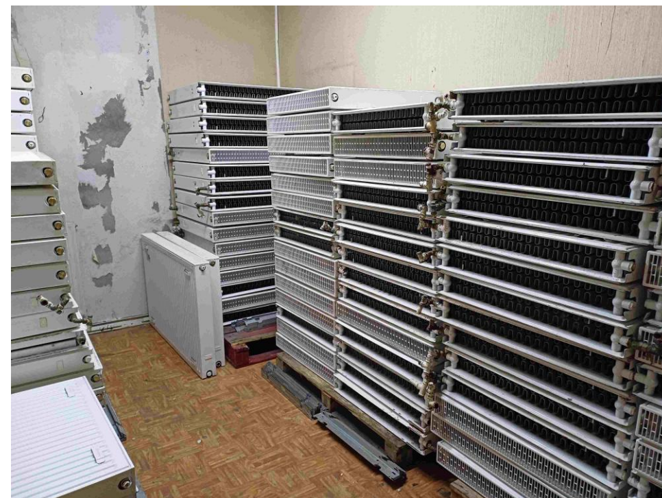
Les radiateurs déposés et stockés (Crédit photo : Patrimoine SA Languedocienne)
