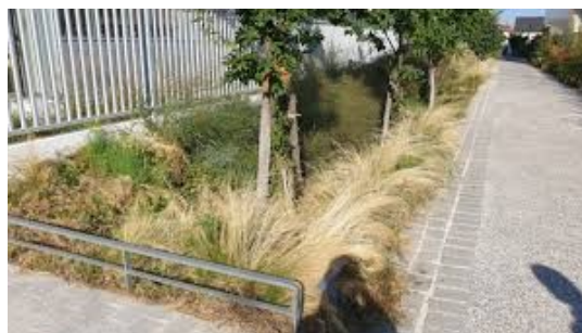
Illustrations de parking perméable et de noues paysagères d'infiltration (Sources : ussplus.fr et ecole Aurea)
