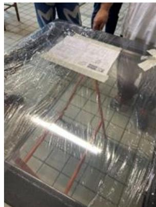
***Fenêtre remise en état, avec attestation de vérification. La remise en état des fenêtres consiste à nettoyer la fenêtre avec un produit naturel LICEF, enlever les joints (silicone, mastic), et changer au besoin la quincaillerie***
