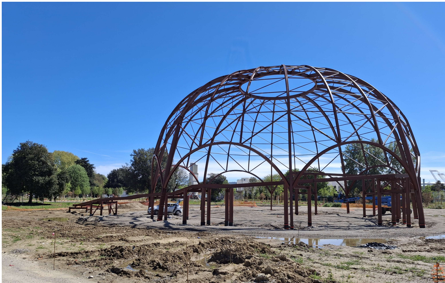
Aire de jeux du futur jardin public en cours de réalisation
