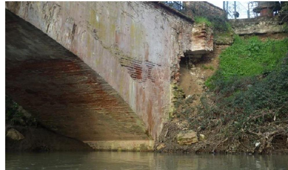
**Ouvrage fermé et abandonné : Importants désordres sur la structure en maçonnerie de briques ainsi que sur les fondations – dispositifs de retenue non conforme pour accueillir du public**
