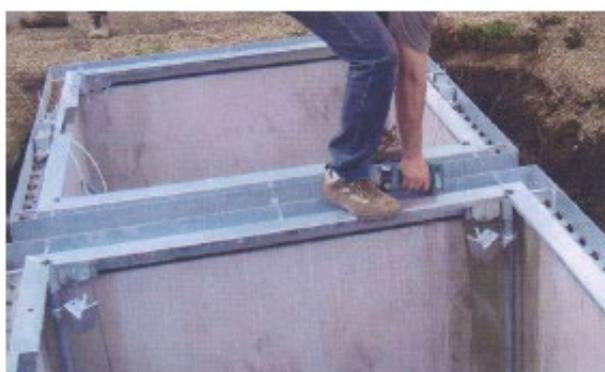
Accrocher les câbles de la plate-forme aux extrémités des contrepoids posés initialement au fond sur les plots béton.
