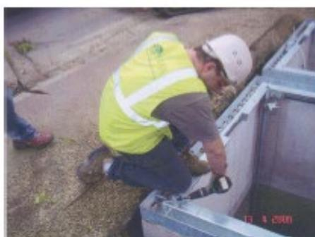
Après la mise en place des tubes, verrouiller l'assemblage par l'insertion de la goupille type mécanindus.
