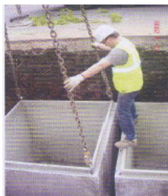
Cette opération est déterminante dans le résultat final, un béton mal posé peut entraîner, après coup, des problèmes de fonctionnement ou d'entrée d'eau.
