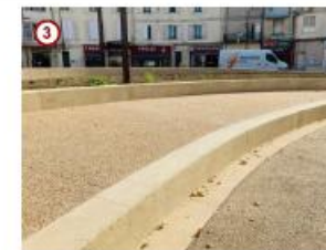
3 - un espace piéton central en béton micro-désactivé
