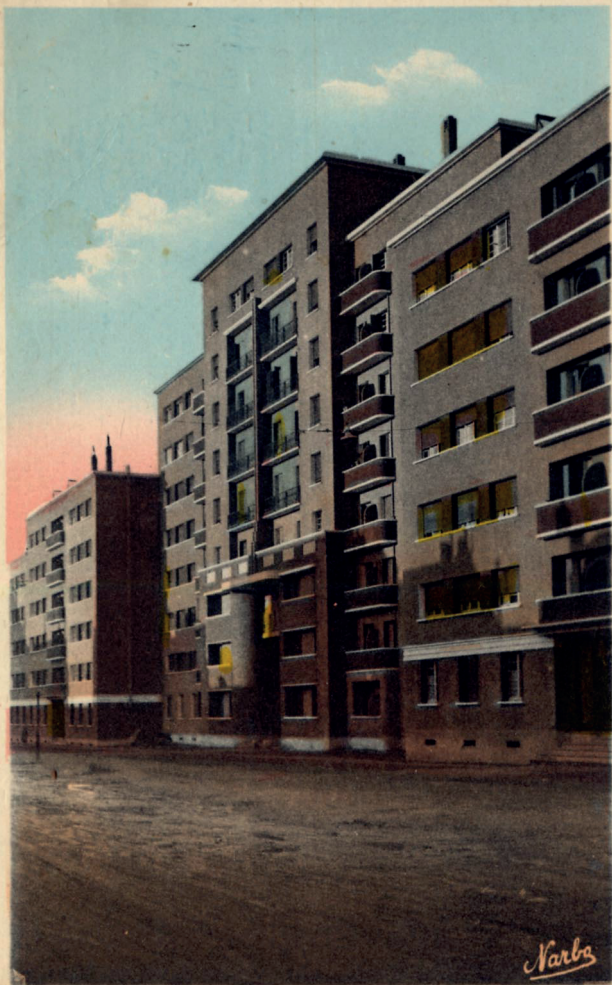
Toulouse — Habitations à Bon Marché - Côté allées des soupirs
