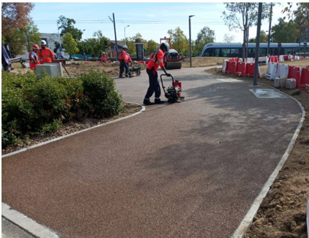
Réfection de la place Georges Brassens à Blagnac — Chantier 100 % électrique
