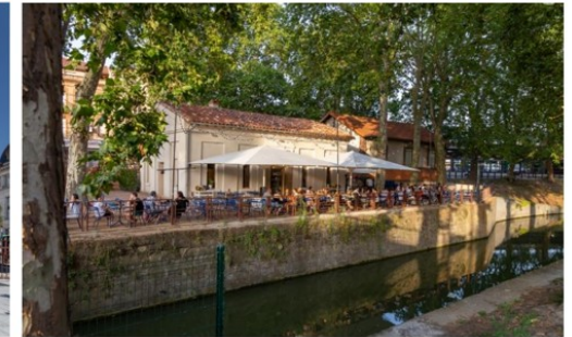
Maison éclésièrè du pont Matabiau, après rénovation
