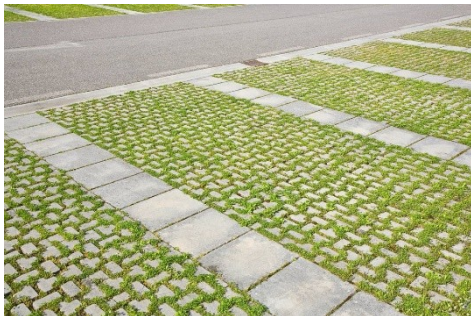
Illustrations de parking perméable et de noues paysagères d'infiltration (Sources : ussplus.fr et ecole Aurea)
