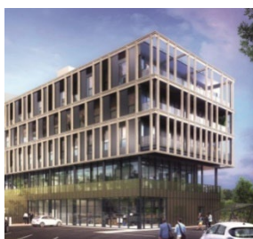
Immeuble mixte à étage
