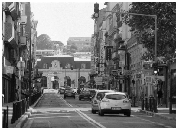
Réaménagement de la rue Bayard avant/après
