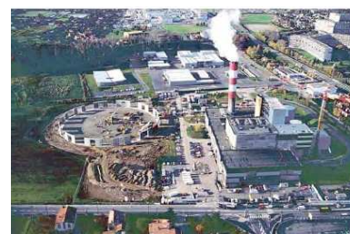
L'Unité de Valorisation Énergétique de Toulouse – Quartier du Mirail
