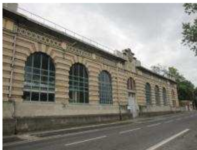
Usine des eaux - Chemin des étroits
