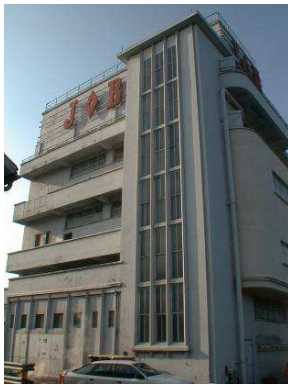
Bâtiment « l'Amiral » de l'ancienne usine JOB : un élément remarquable du patrimoine bâti contemporain
