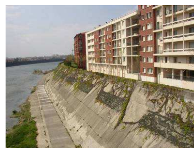
La digue bétonnée, une protection renforcée contre les crues du fleuve- vers le secteur d'Anceley
