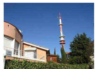
Emetteur radio : un élément de près de 25m de haut qui domine les habitations environnantes
