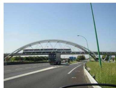
La rocade et la passerelle du métro vers Balma-Gramont : nouvelles portes urbaines
