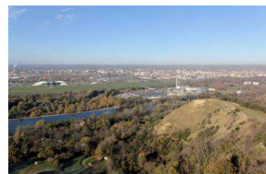
Le site du SNPE et de l'Oncopole, éléments au cœur d'un nouveau projet d'envergure, en compatibilité avec l'environnement urbain et naturel
