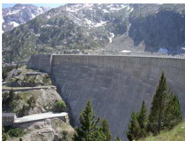
Barrage de Cap de Long dans les Hautes-Pyrénées Source : http://sitepasite.free.fr
