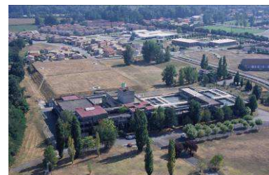
L'usine de Clairfont
