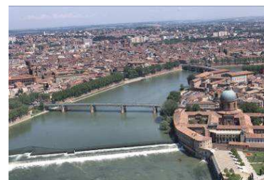
Vue aérienne de la Garonne - chaussée du Bazacle
