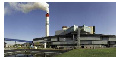
L'Unité de Valorisation Énergétique de Toulouse – Quartier du Mirail
