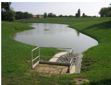
Bassin de rétention d'eau : un élément à la fois technique et paysager
