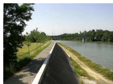
La digue talutée et enherbée dans en limite Nord de Toulouse
