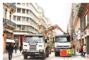
Un chantier rue Alsace-Lorraine
