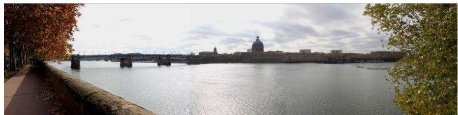
Depuis le Quai Saint Pierre : ouverture visuelle sur
