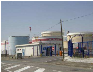
Le site ESSO SAF, avenue de Fondeyre : installation dangereuse soumise à Autorisation avec Servitudes
