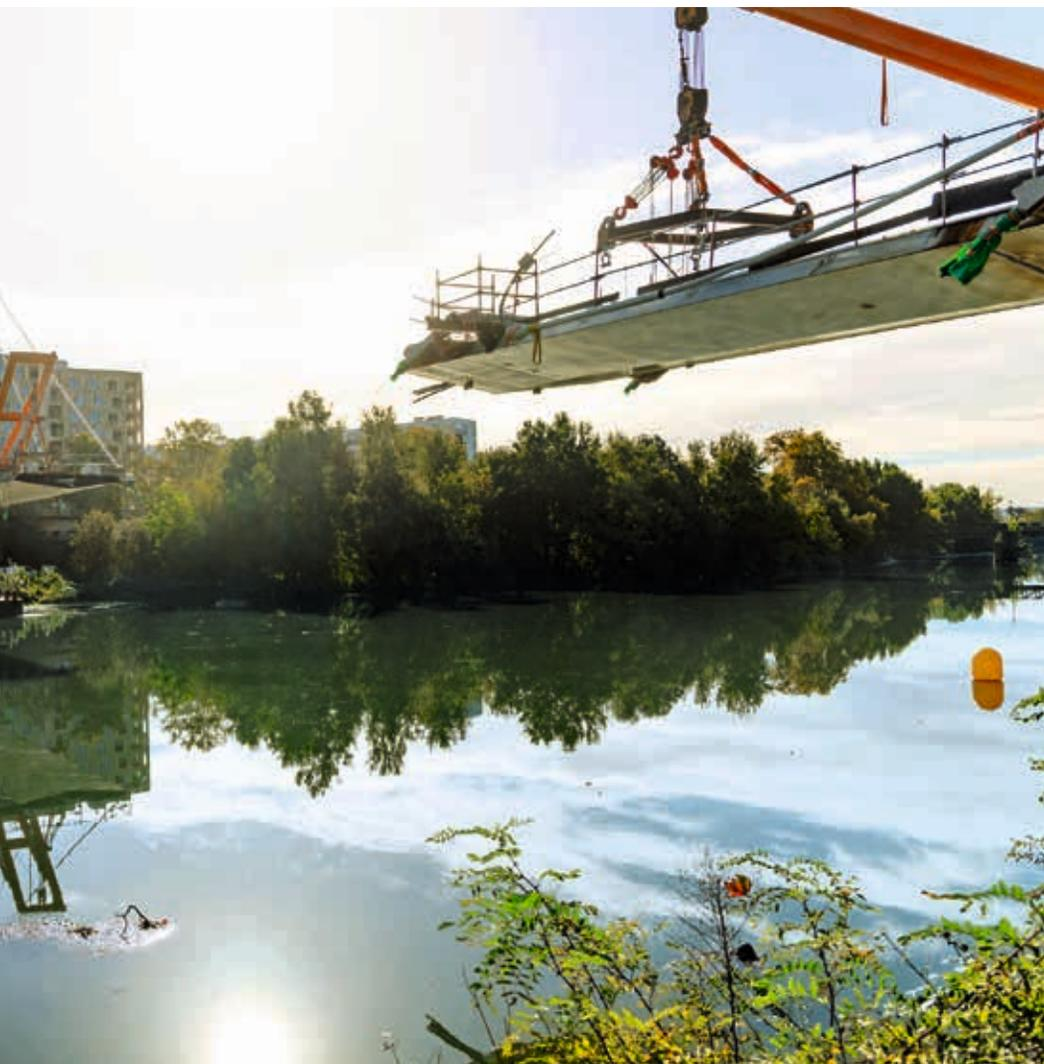
trait sur la Garonne, soutenu par deux pylônes et des haubans à ses extrémités, sans appui dans le fleuve pour protéger la biodiversité. Conçus en métal (tablier) et en béton (rampes et appuis), les deux ouvrages allient robustesse, finesse et élégance. Des objets architecturaux dessinés par Thomas Lavigne (Empalot) et Grimshaw/PPA Architectures (Rapas).
