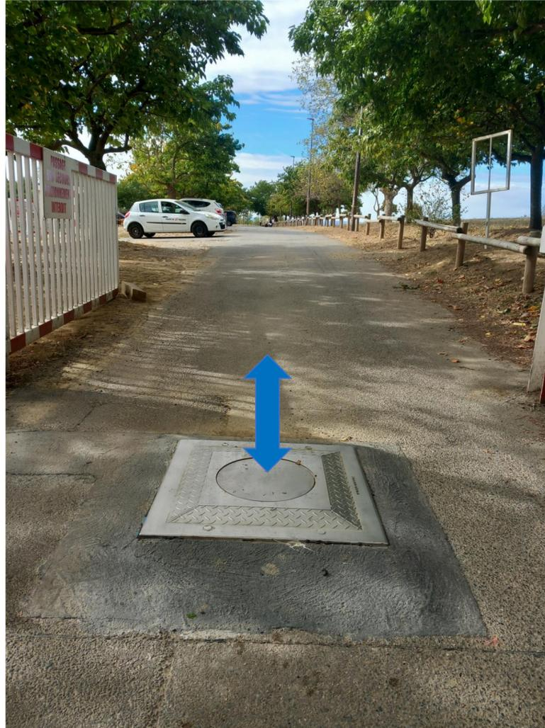
Installation d'une borne escamotable pour permettre :
