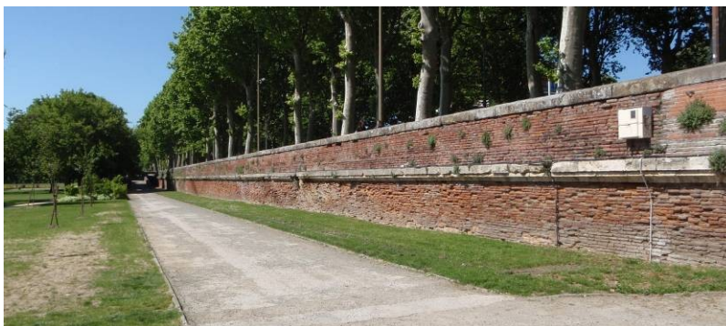
Le cours Dillon fait partie du dispositif de protection de la Ville de Toulouse contre les crues de la Garonne
