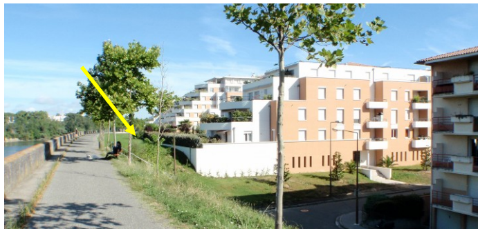
Construction sur l'ancien site JOB avec renforcement de la digue et bâti peu vulnérable
