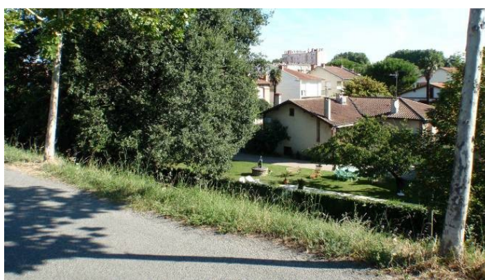
Pavillons très proches de la digue des Sept-Deniers
