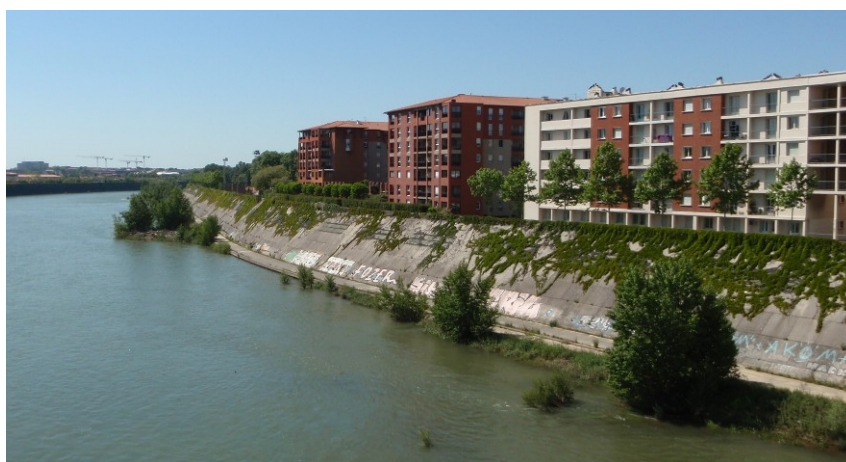
Digue en terre revêtue par un parement en béton armé aux Amidonniers
