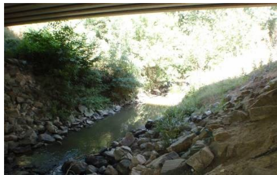
Vue sous le pont de la RD 59 avant la gare de péage
