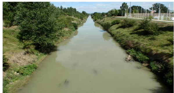
L'Hers-Mort au pont de Balma Vue vers le nord du recalibrage
