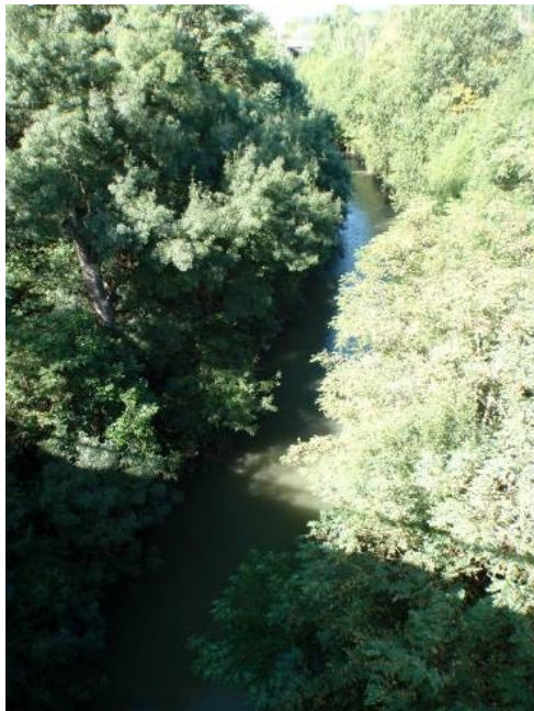
Le Touch encaissé dans sa partie aval Vue depuis le pont de l'Avenue des Arènes Romaines
