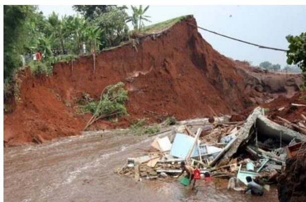
Rupture de digue en Indonésie en août 2009, source AFP
