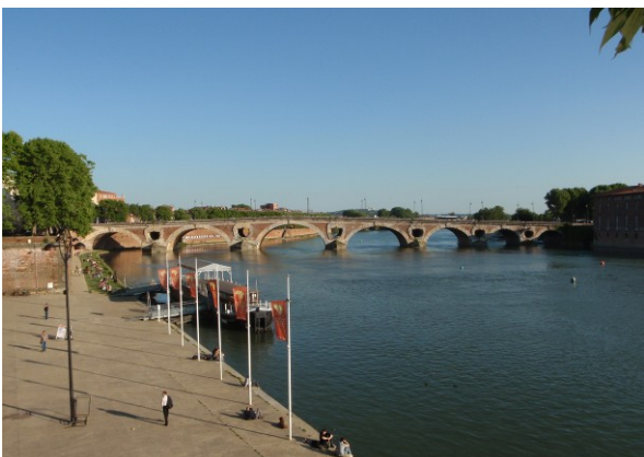
Le Pont-Neuf sur la Garonne, seul pont toulousain ayant résisté à l'assaut de la crue de juin 1875
