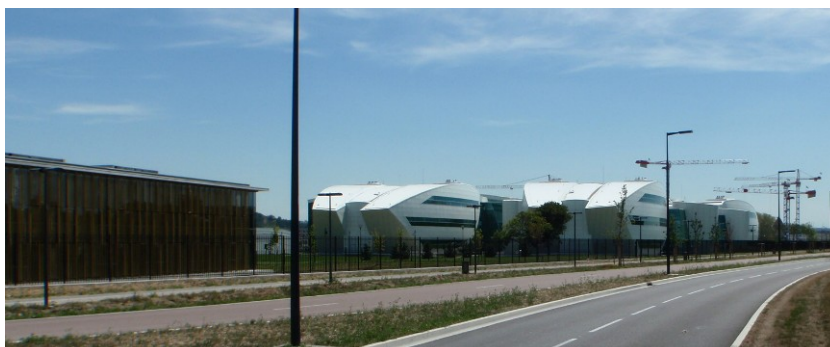
Cancérôpole en construction
