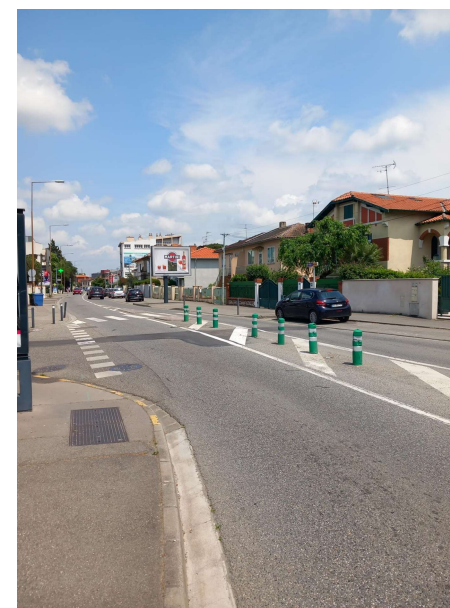
Sécurisation du carrefour Agde / Lenotre
