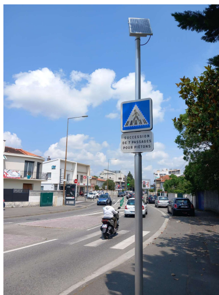
Implantation de panneaux lumineux solaires indiquant la succession de plusieurs traversées piétonnes
