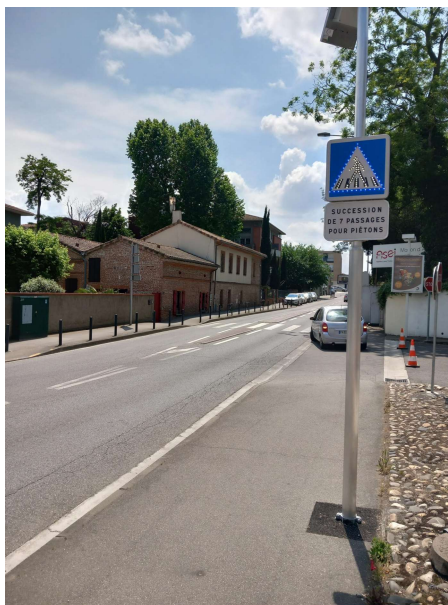
Implantation de panneaux lumineux solaires indiquant la succession de plusieurs traversées piétonnes
