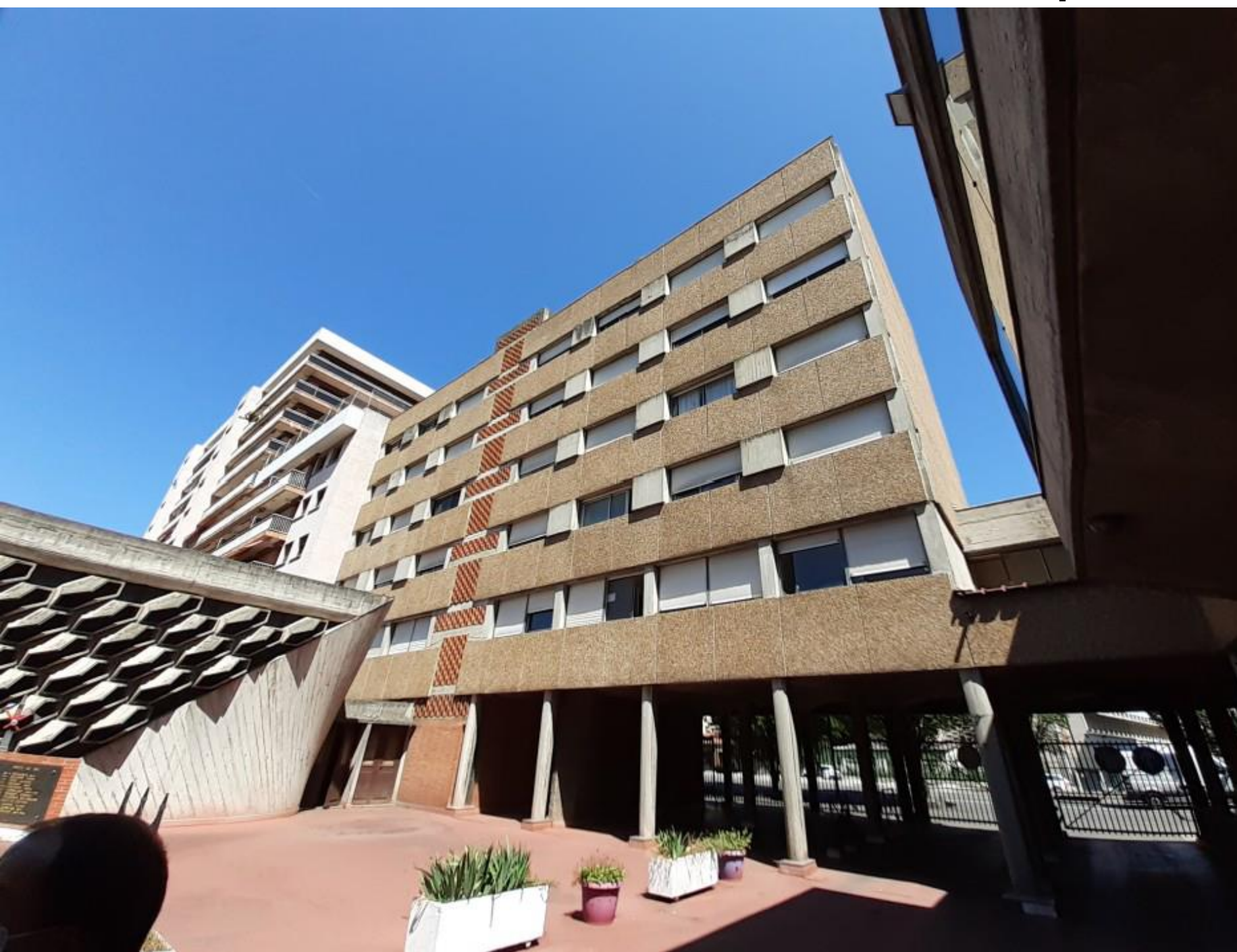
L'immeuble de 5 étages, côté cour
