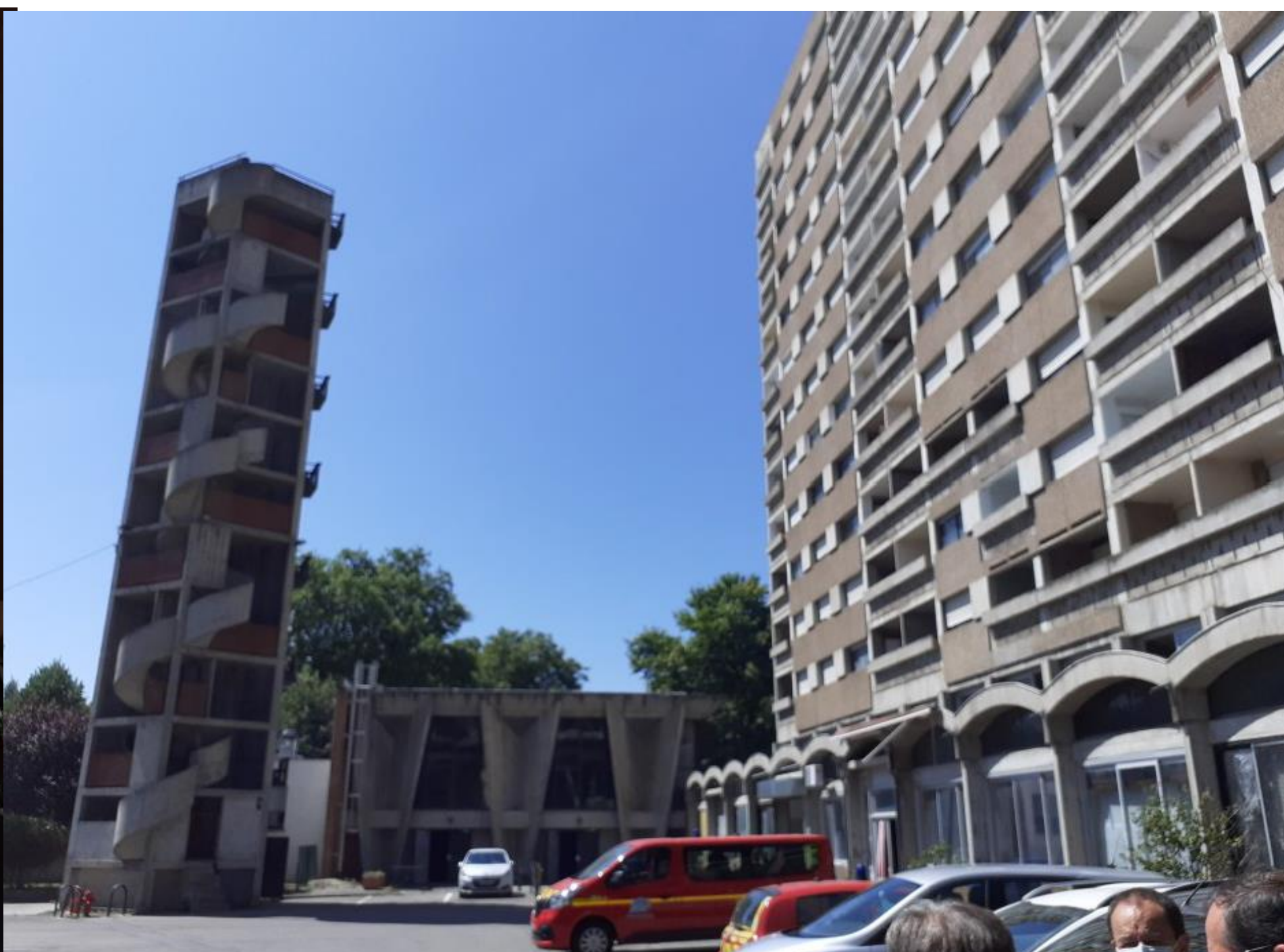
Bâtiment d'habitation et tour de séchage
