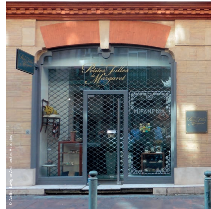
Des solutions qui respectent l'architecture et mettent en valeur la vitrine la nuit: la grille implantée derrière la vitrine, la grille ajourée, le verre de sécurité.
