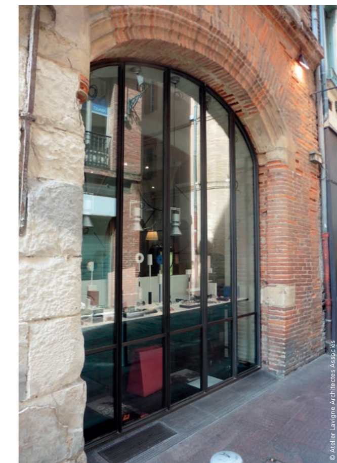
La partition, les profils fins respectent et mettent en valeur l'arc et ses moulures.
