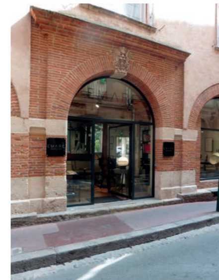
Traditionnellement, les seuils sont bâtis en grès (pierre dure et résistante) et forment la transition entre le soubassement* (ici en calcaire) et le trottoir.
