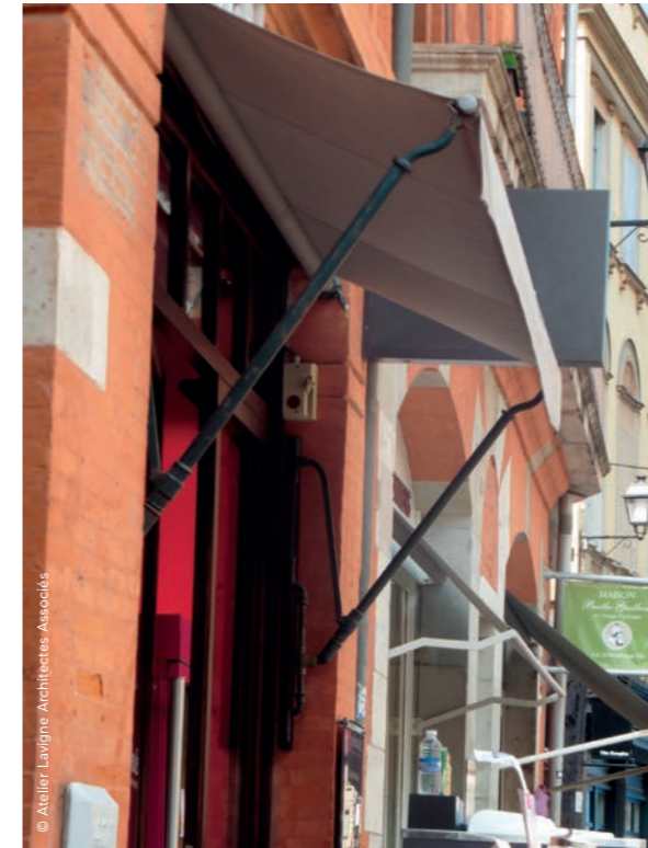
Les bras des stores* sont fins et peuvent être ouvragés. Ils sont fixés sur la menuiserie de la devanture*.
