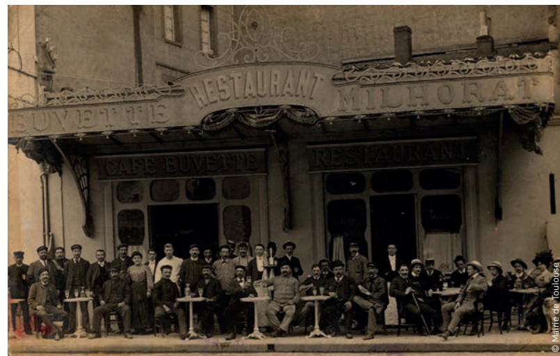
Le motif de la marquise lié à l'architecture du XIX e siècle, rue de Bayard.
