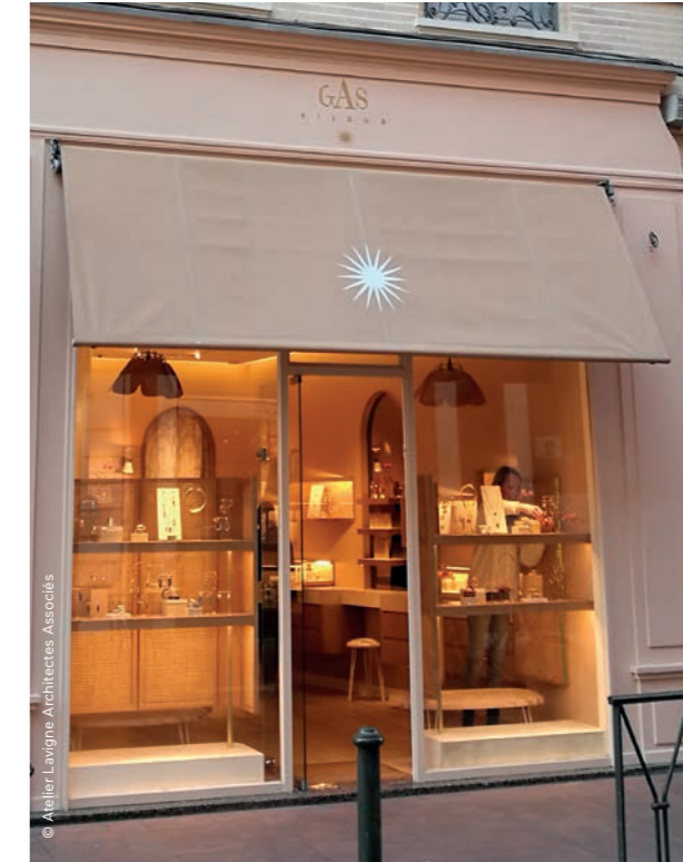
Les bras des stores* sont fins et peuvent être ouvragés. Ils sont fixés sur la menuiserie de la devanture*.
