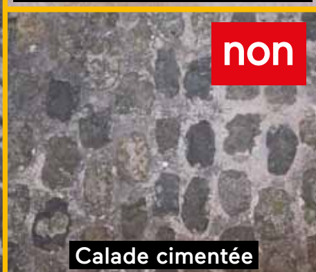
Calade recouverte de béton
