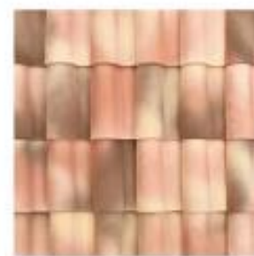
Toit en tuiles canal
