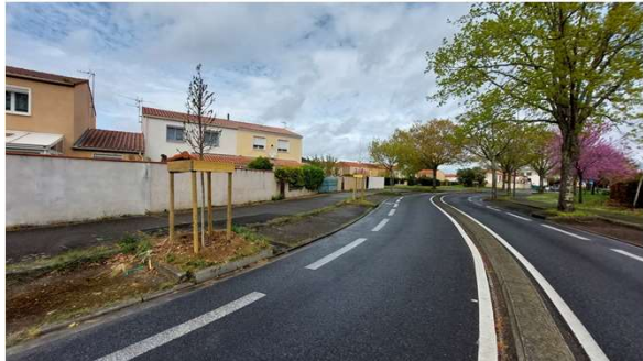
Renouvellement d'arbres sur l'Avenue Huc
