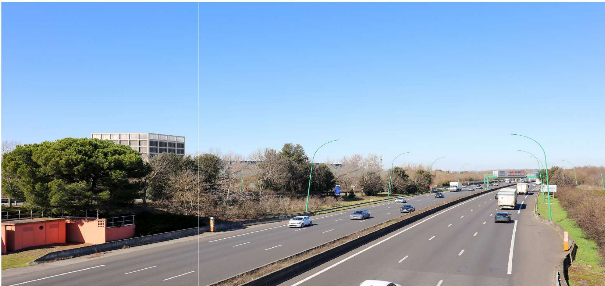
Construction d'un Technocentre sur le site Atlanta Vue depuis la rocade
