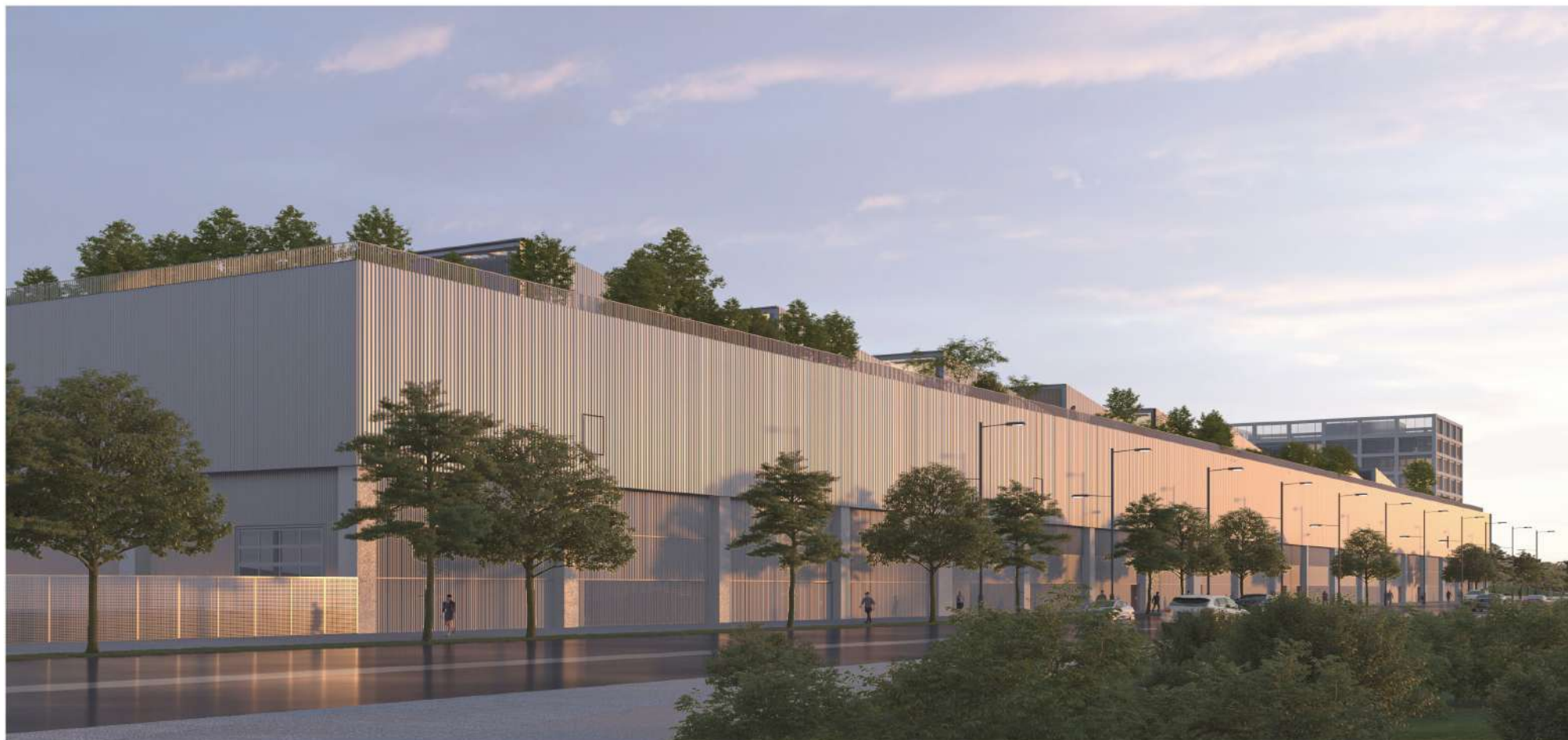
Construction d'un Technocentre sur le site Atlanta Vue Avenue d'Atlanta Nord
