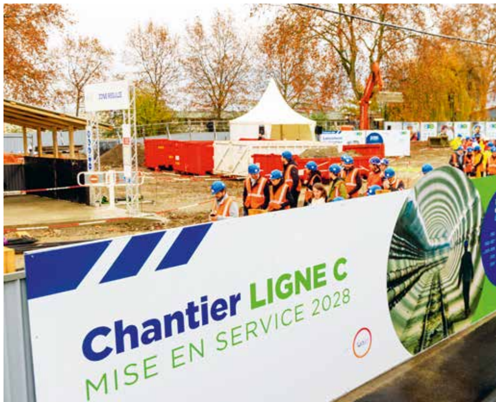
Coup d'envoi du chantier de la 3 e ligne le 15 décembre 2022 aux Sept-Deniers.
