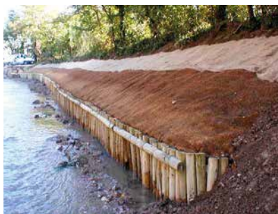
Les pieux jointifs
