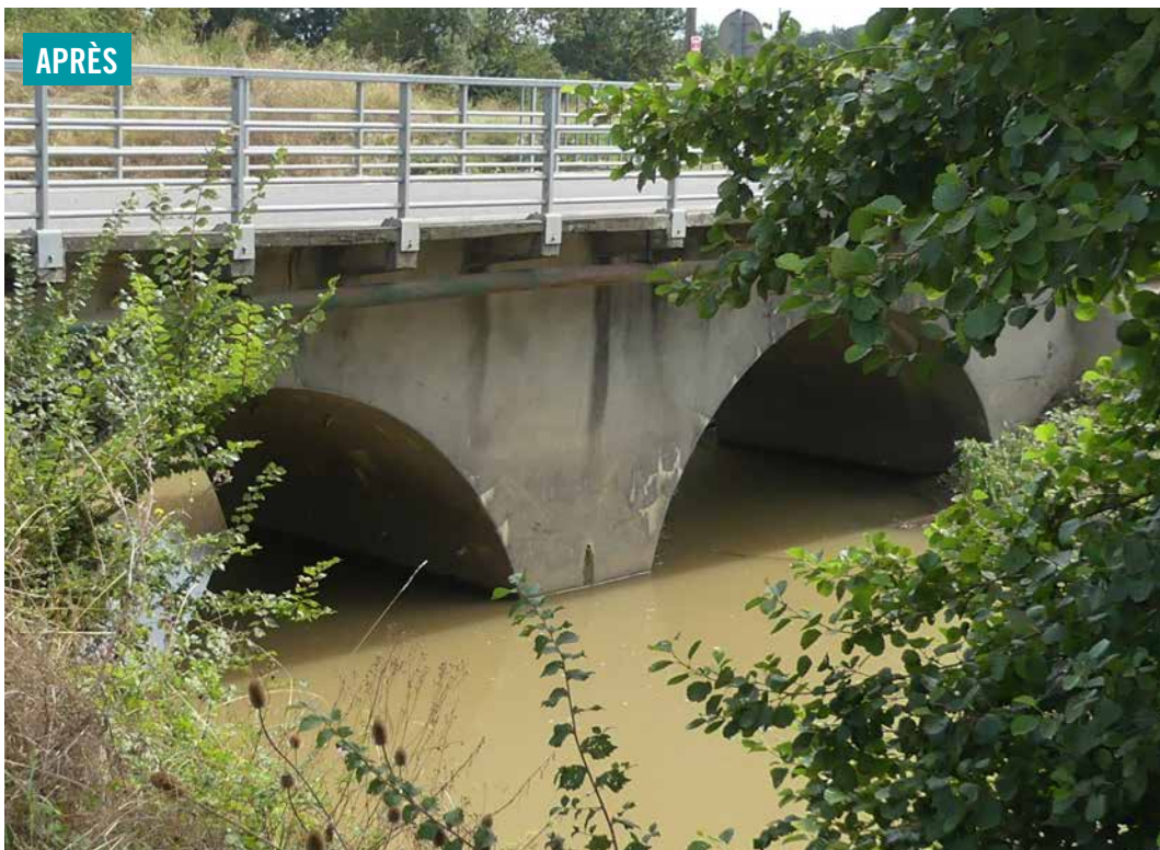
Pont de l'enseigne à Aussonne après intervention.
