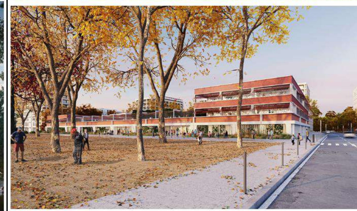
Lot MG4 – Azur Toulouse Métropole Habitat Construction du Groupe scolaire
