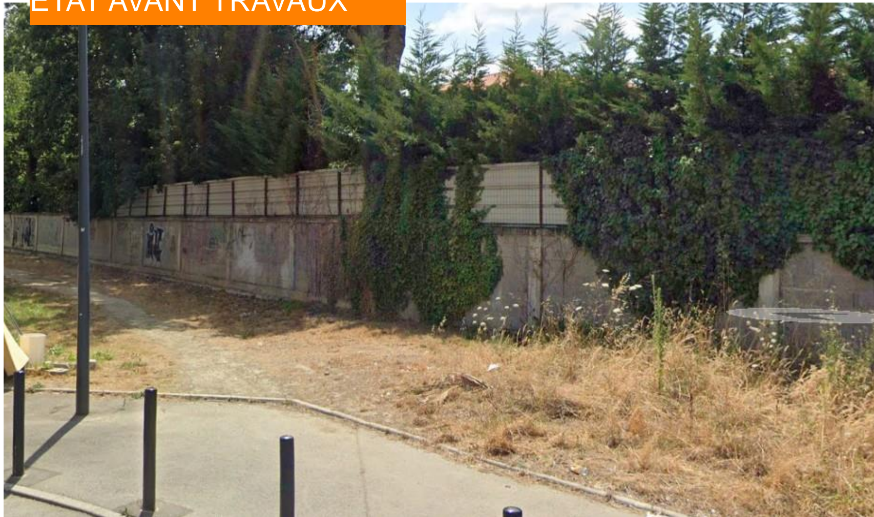
ÉTAT AVANT TRAVAUX
