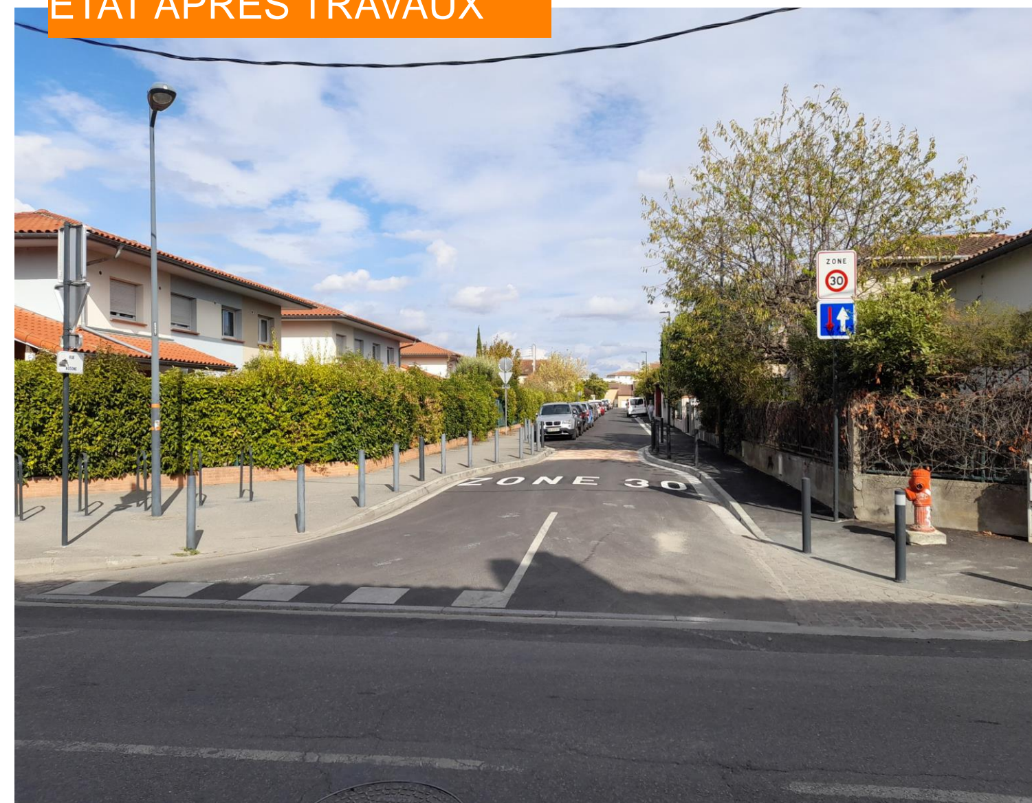
ÉTAT APRÈS TRAVAUX
