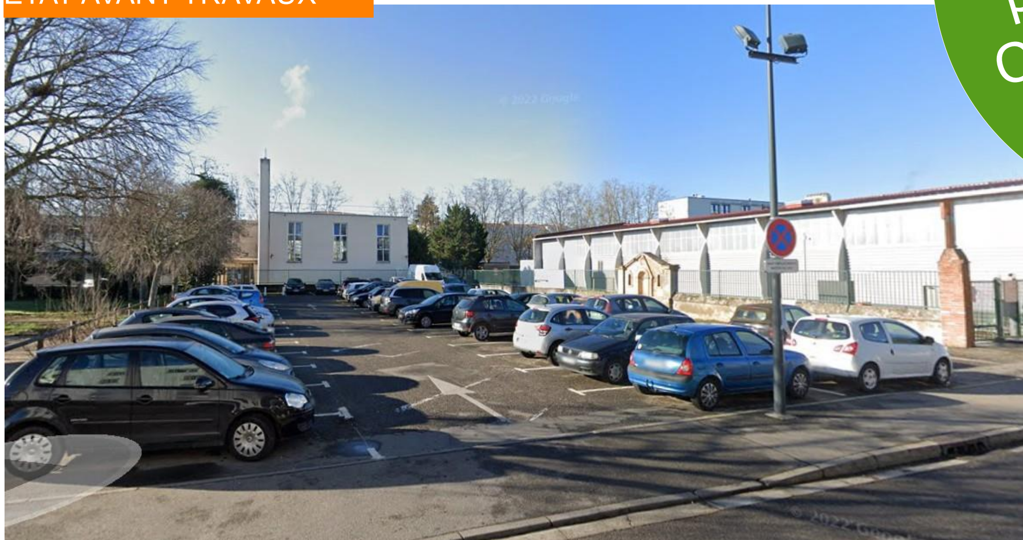
ÉTAT AVANT TRAVAUX
