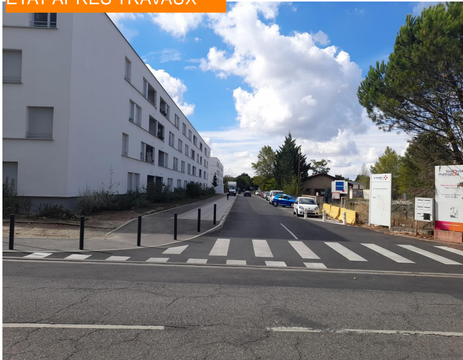
ÉTAT APRÈS TRAVAUX
