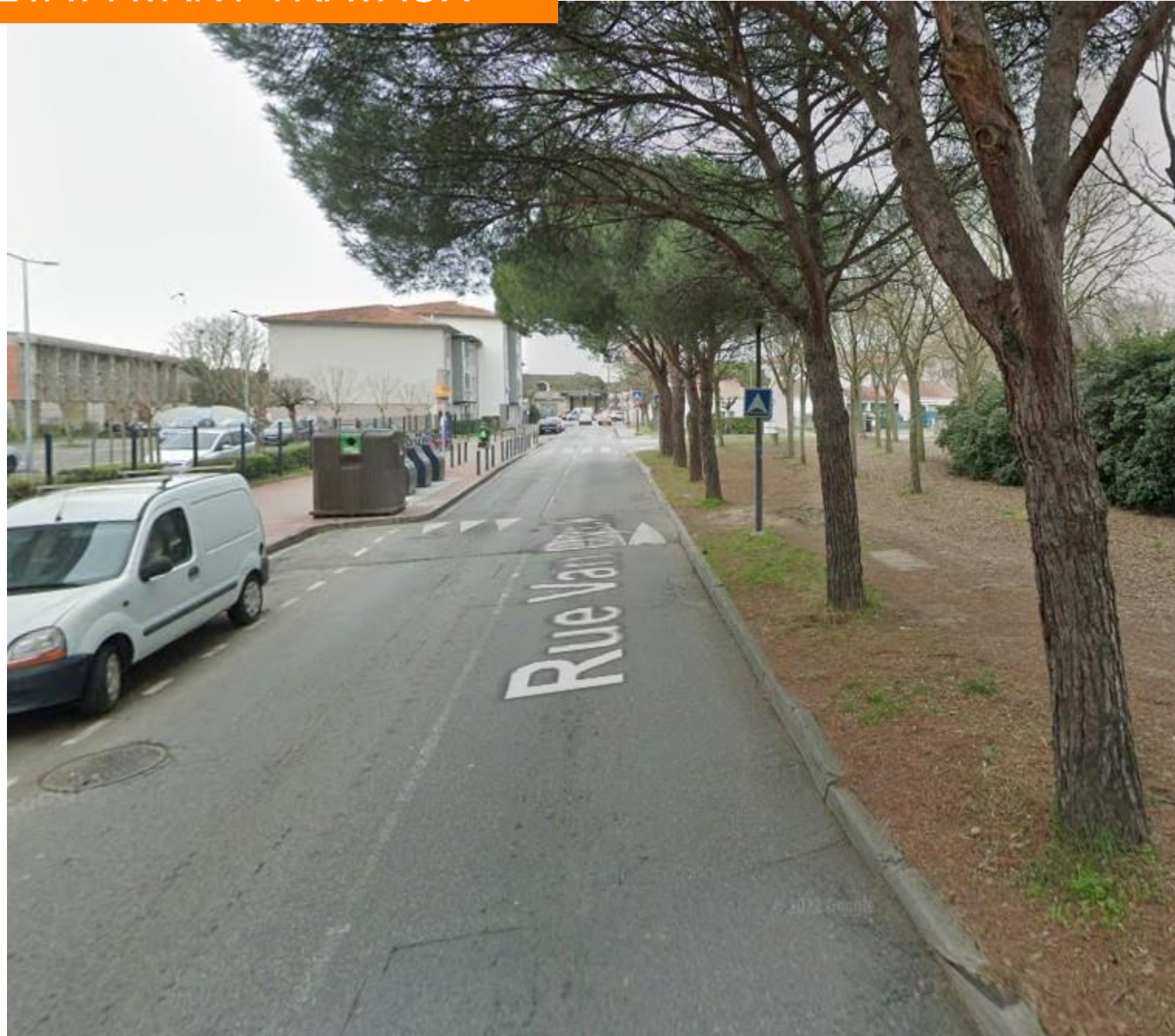
ÉTAT AVANT TRAVAUX
