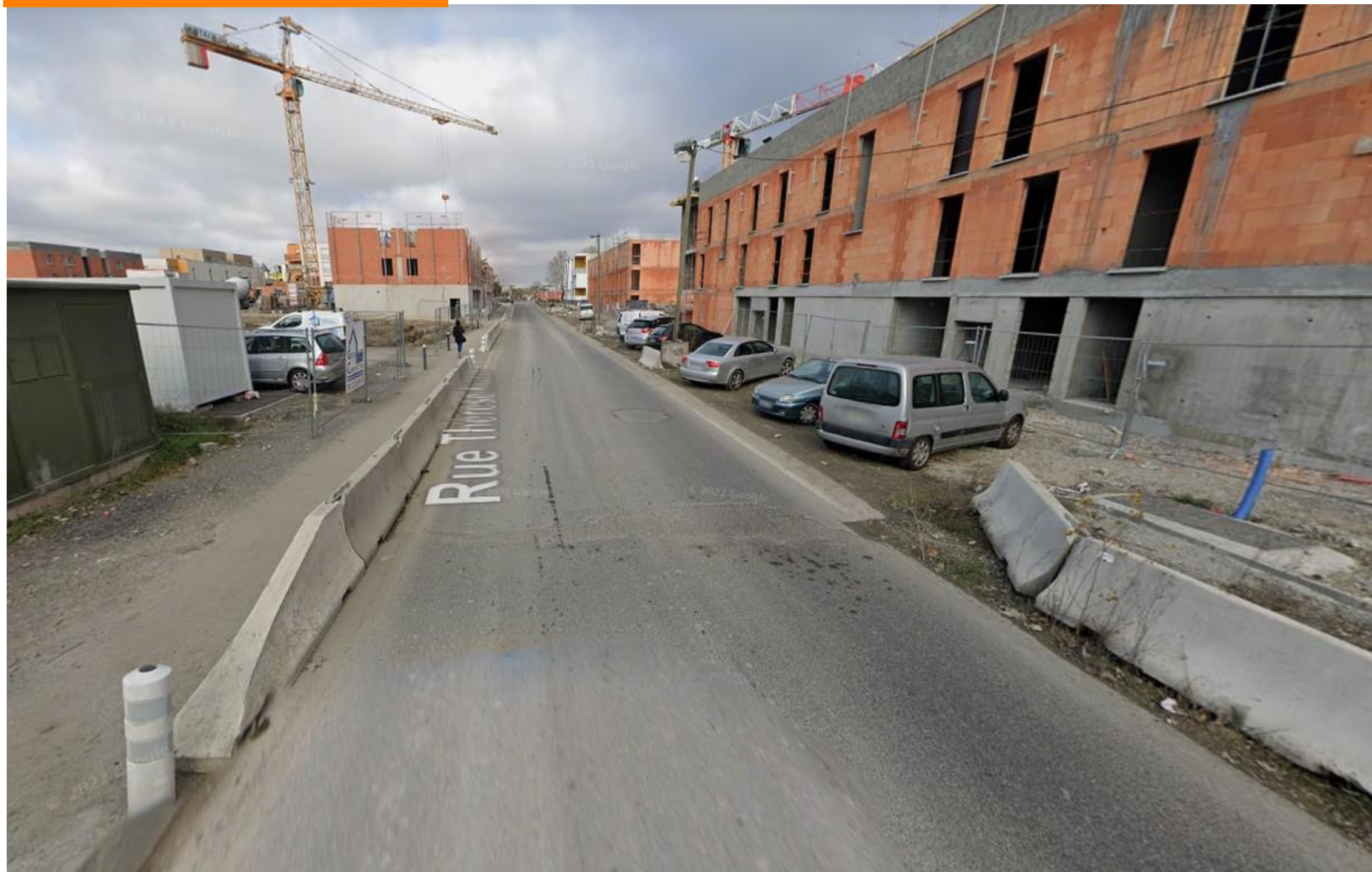
ÉTAT AVANT TRAVAUX
