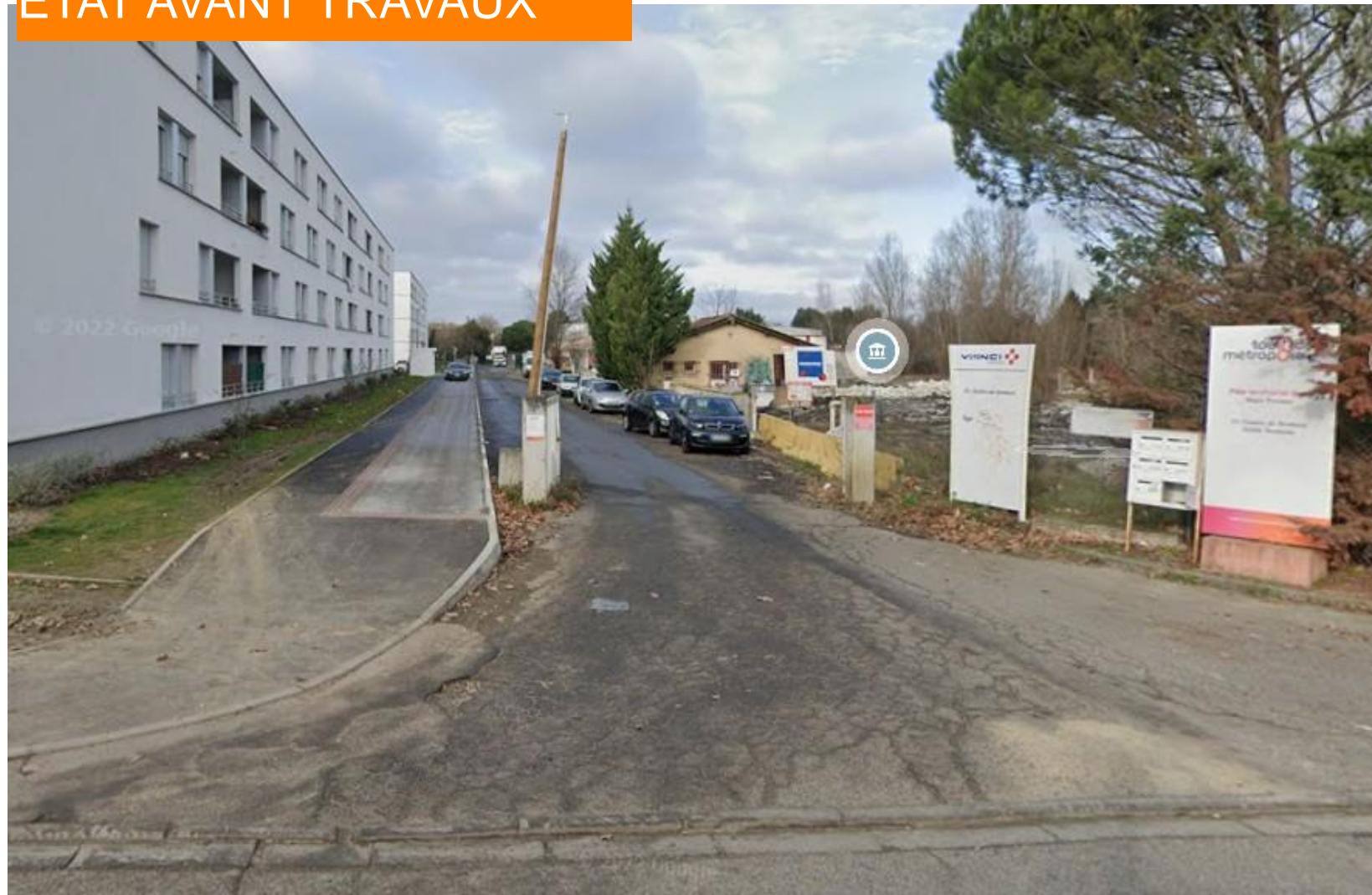
ÉTAT AVANT TRAVAUX
