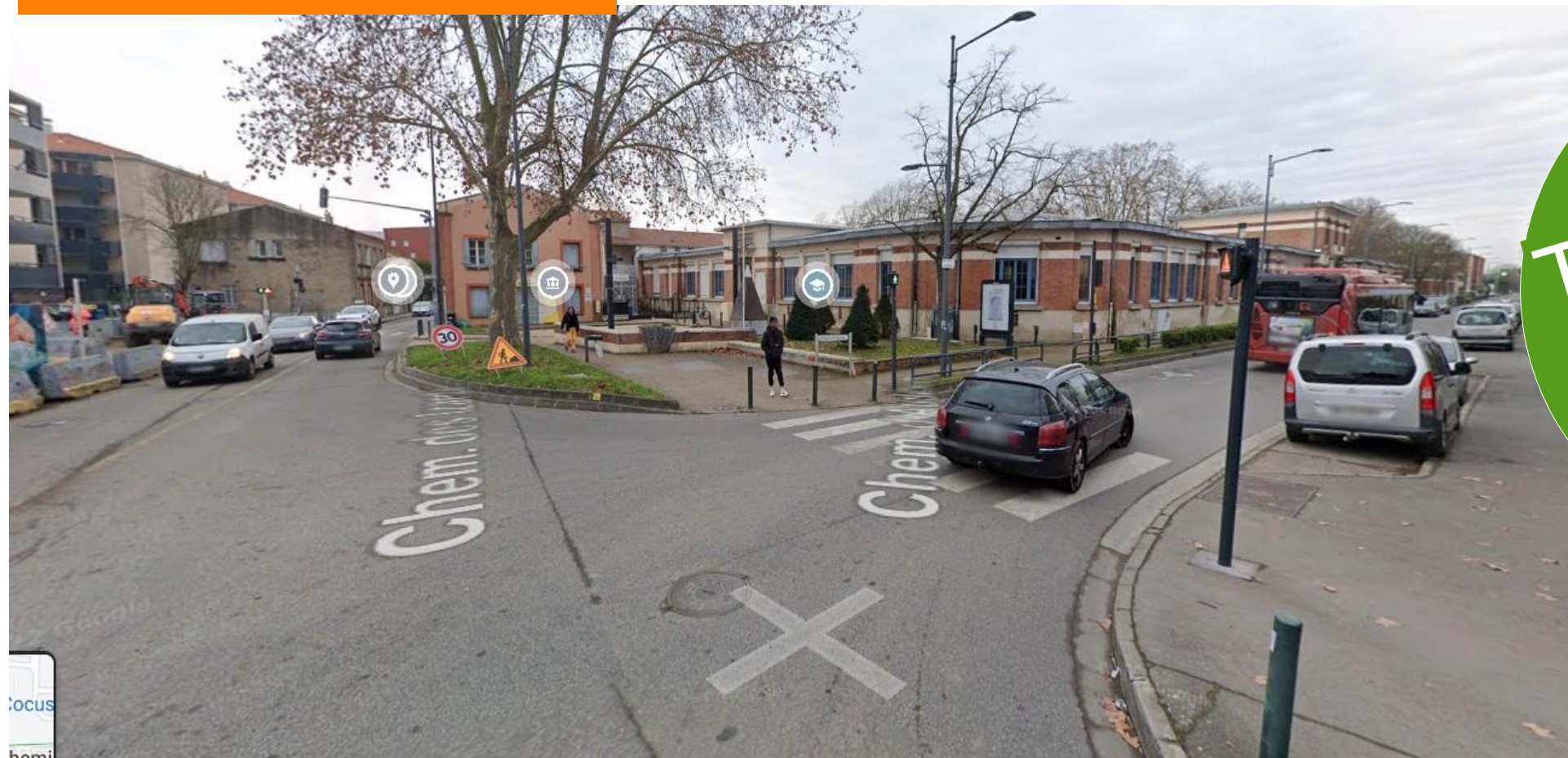
ÉTAT AVANT TRAVAUX
