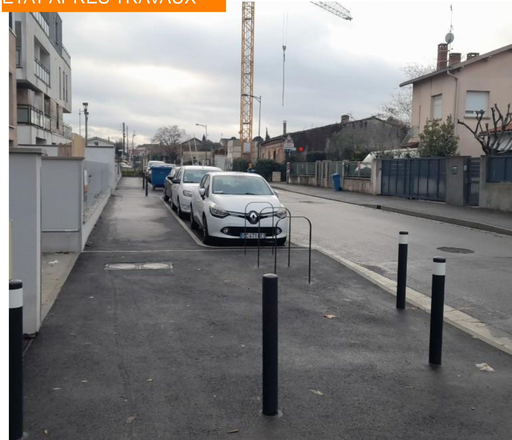
ÉTAT APRÈS TRAVAUX
