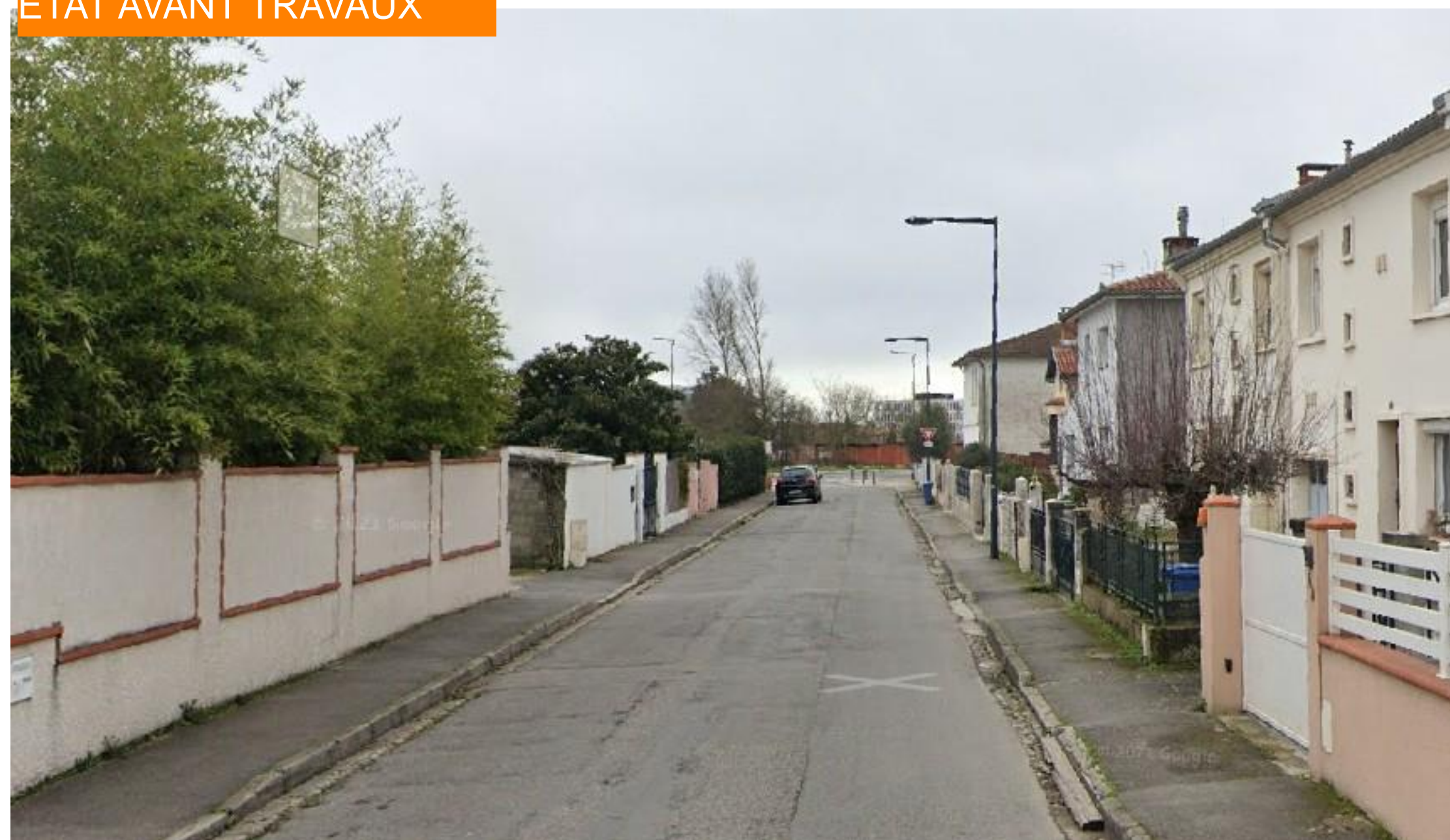
ÉTAT AVANT TRAVAUX
