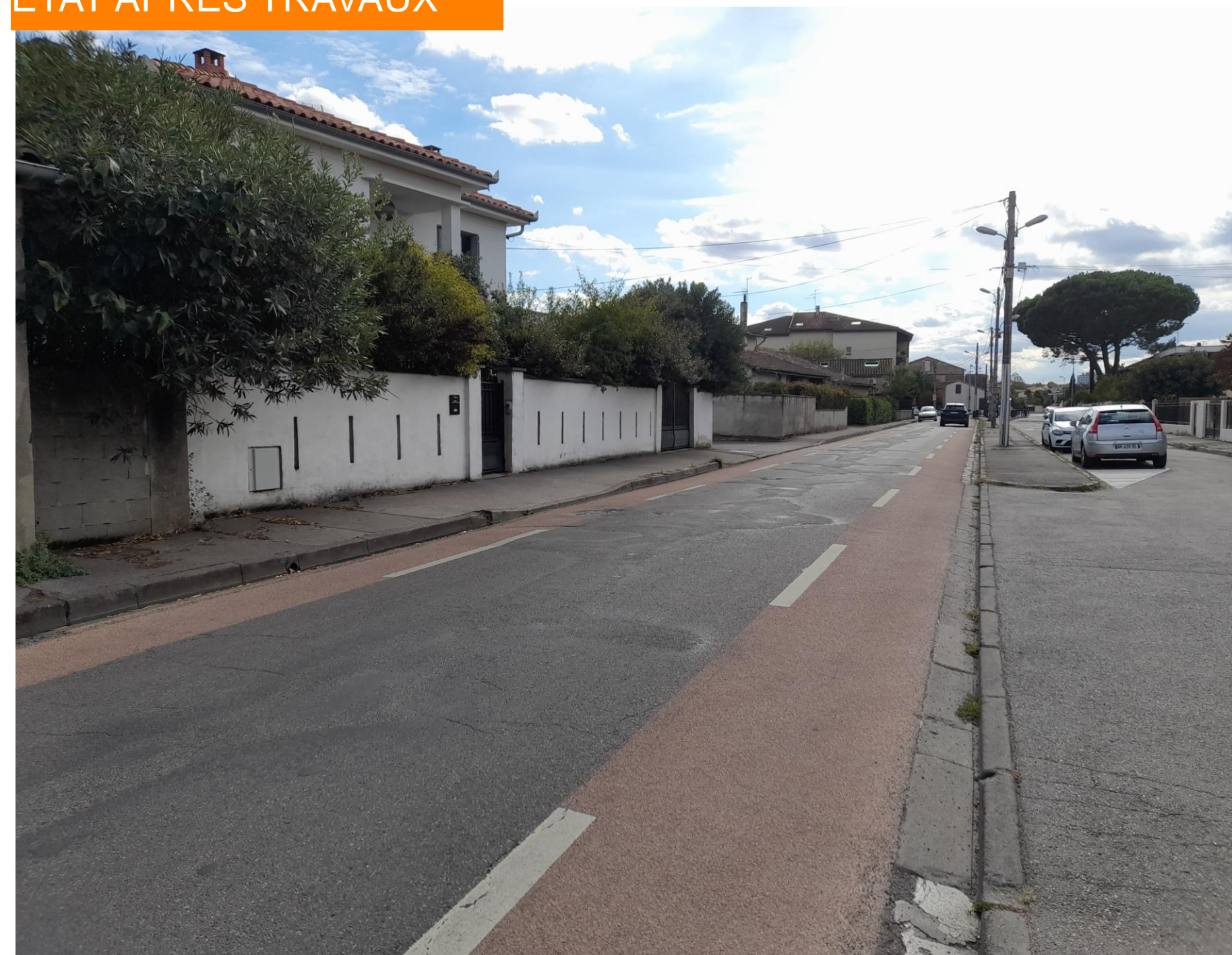
ÉTAT APRÈS TRAVAUX
