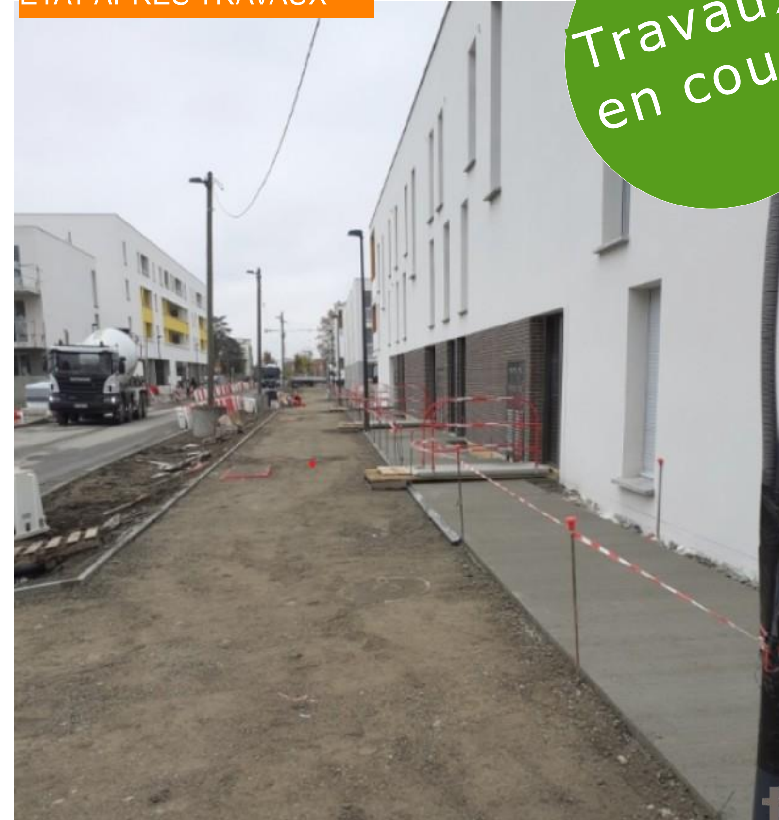
ÉTAT APRÈS TRAVAUX
