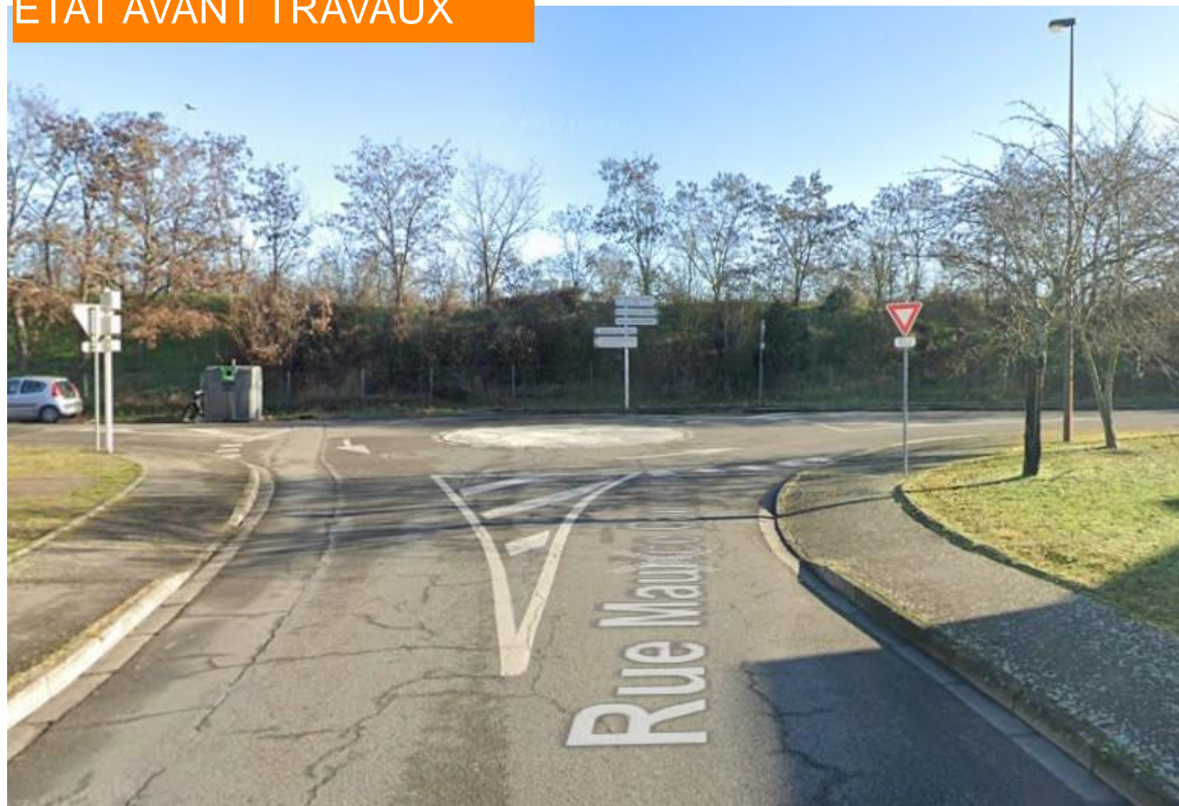
ÉTAT AVANT TRAVAUX
