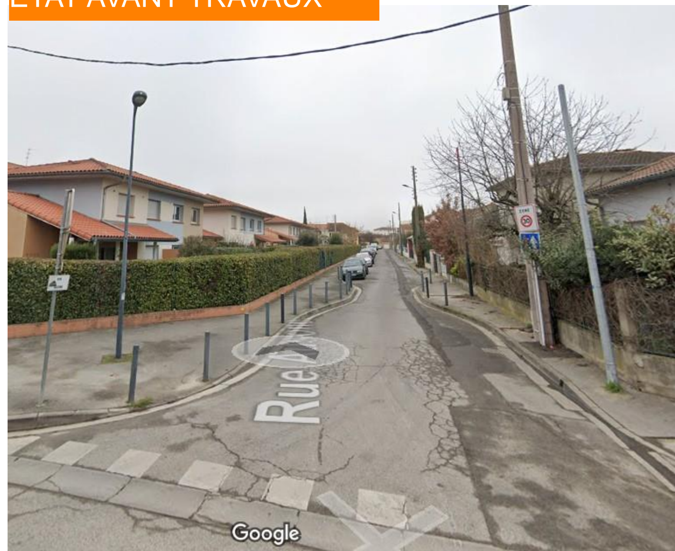
ÉTAT AVANT TRAVAUX
