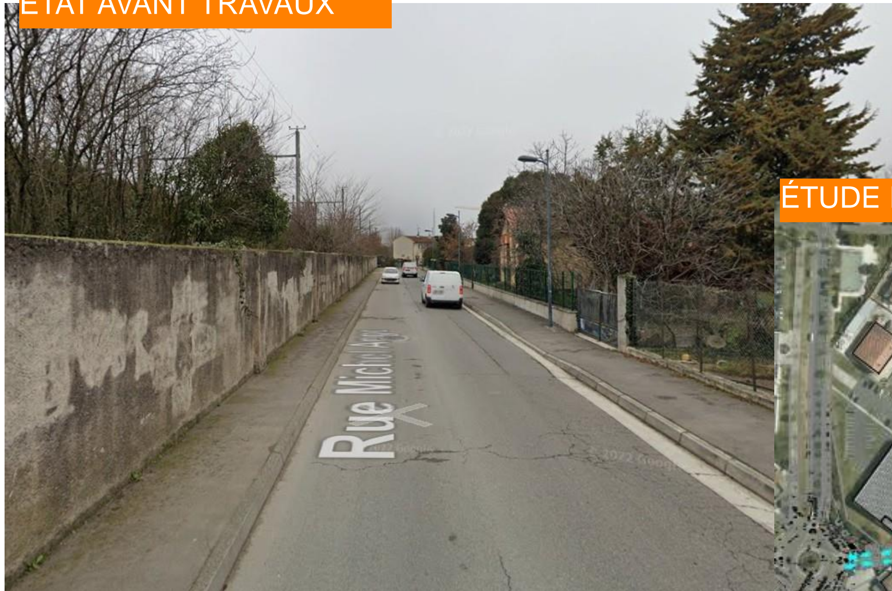
ÉTAT AVANT TRAVAUX
