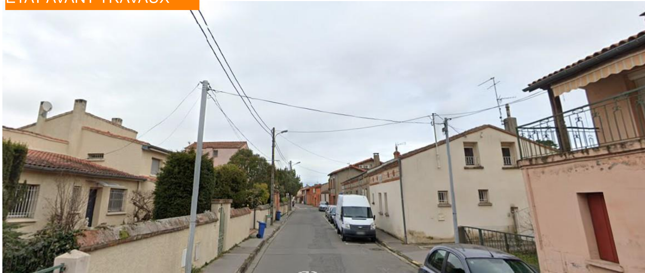
ÉTAT AVANT TRAVAUX
