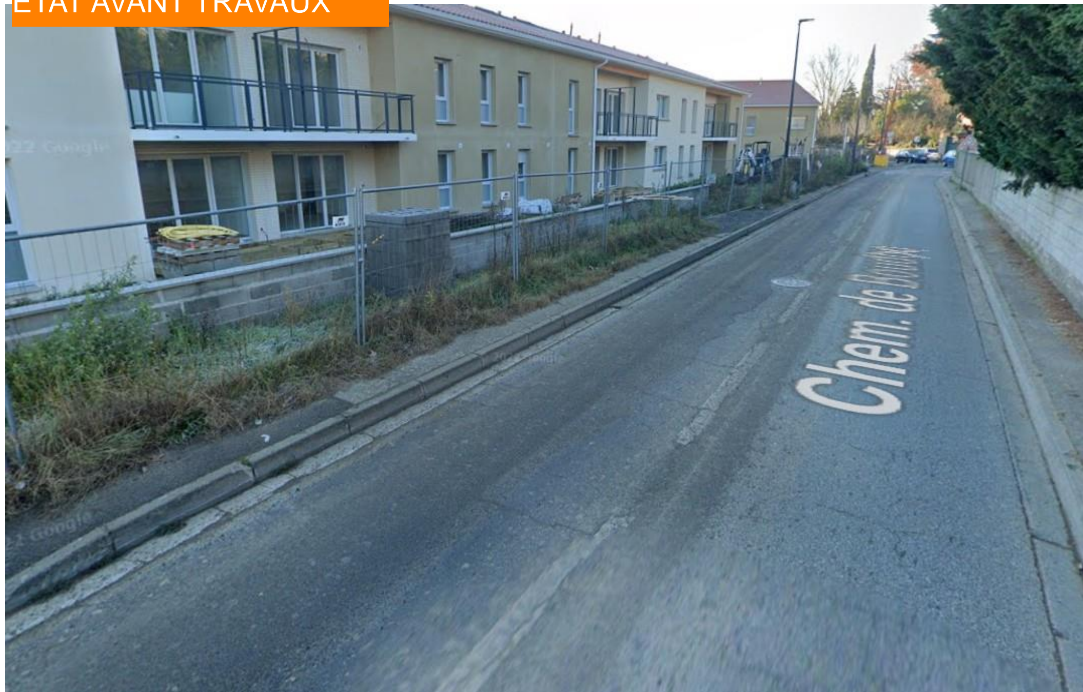
ÉTAT AVANT TRAVAUX
