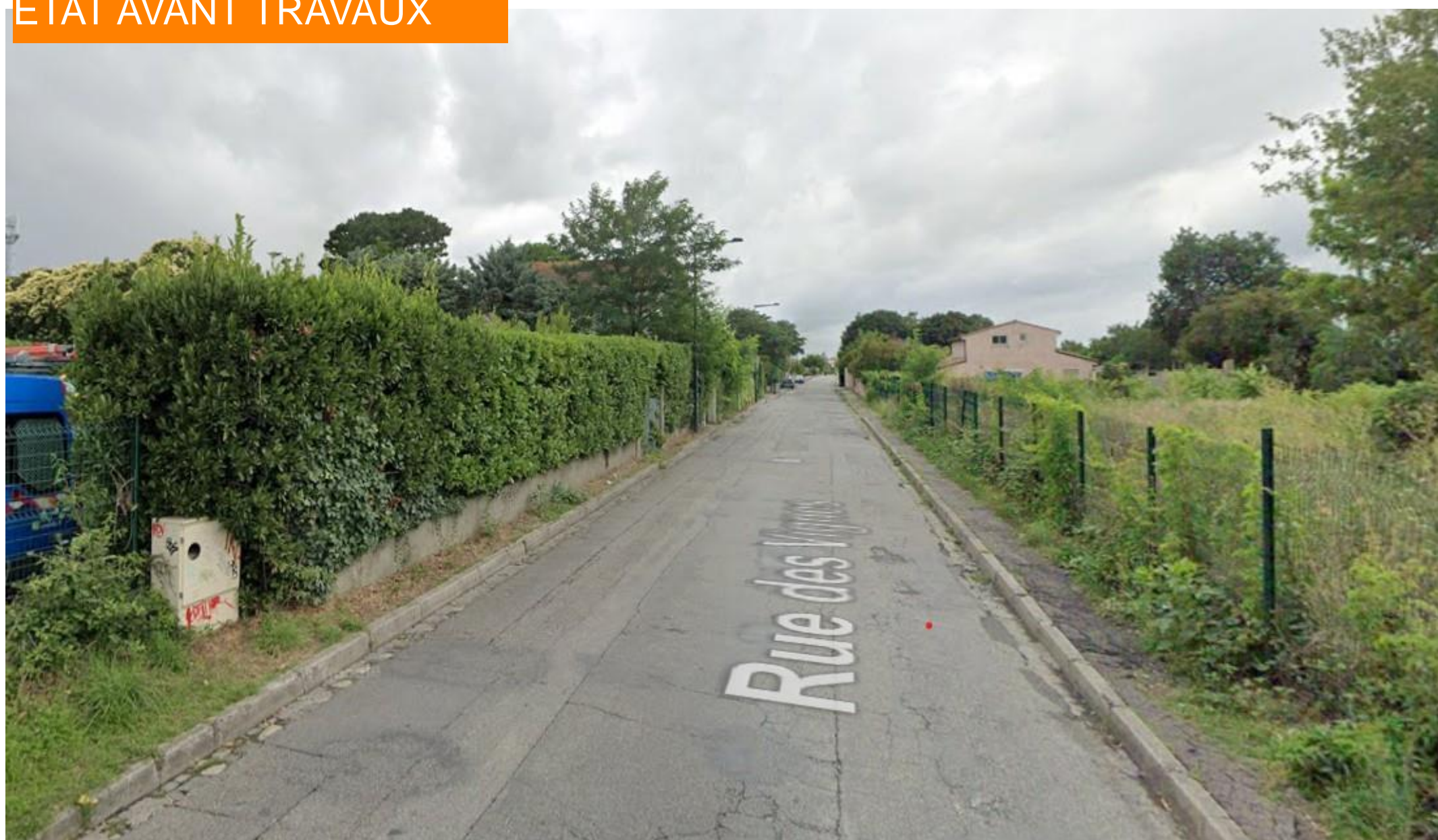
ÉTAT AVANT TRAVAUX
