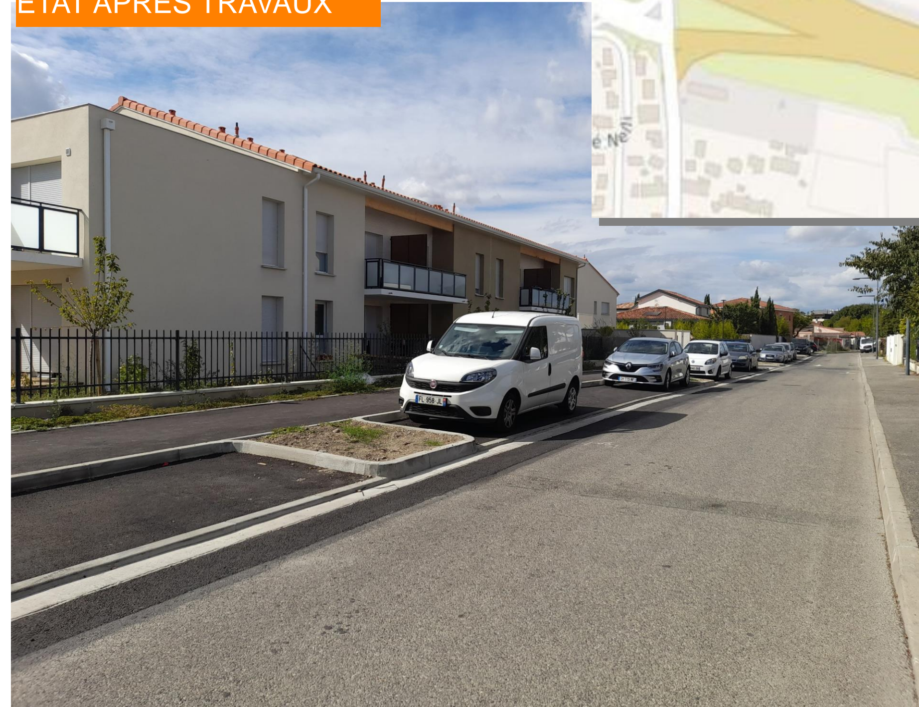
ÉTAT APRÈS TRAVAUX
