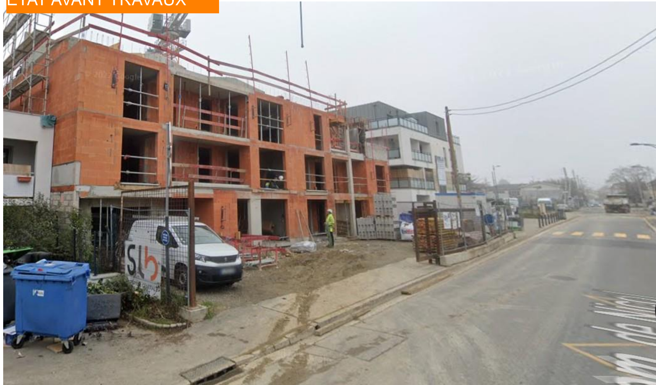
ÉTAT AVANT TRAVAUX
