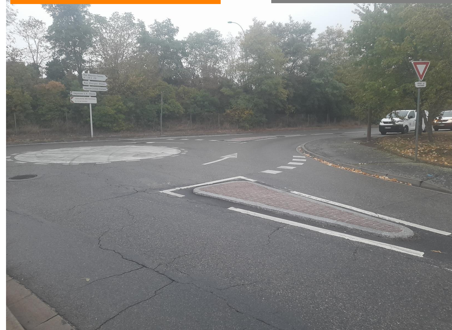
ÉTAT APRÈS TRAVAUX
