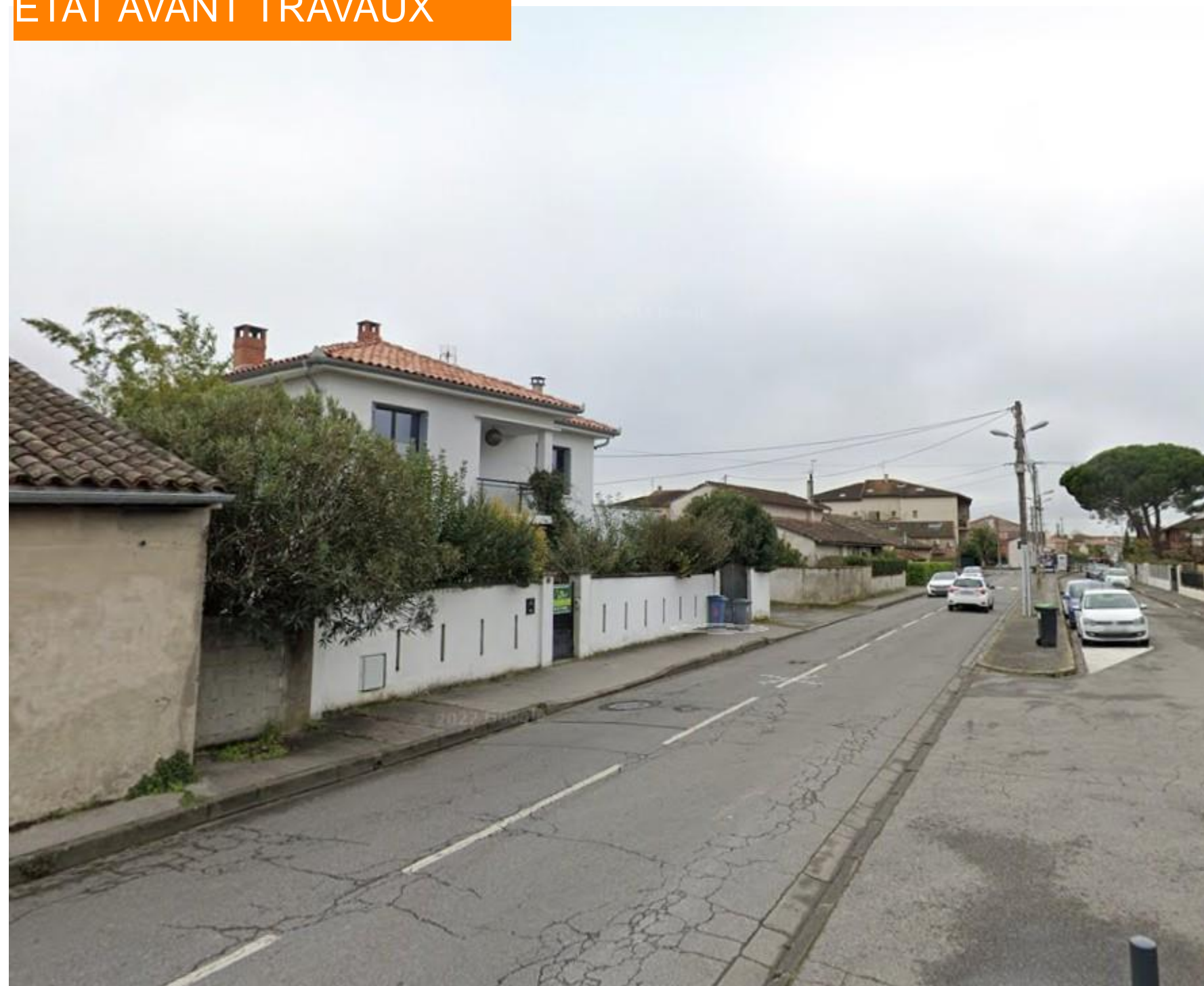
ÉTAT AVANT TRAVAUX
