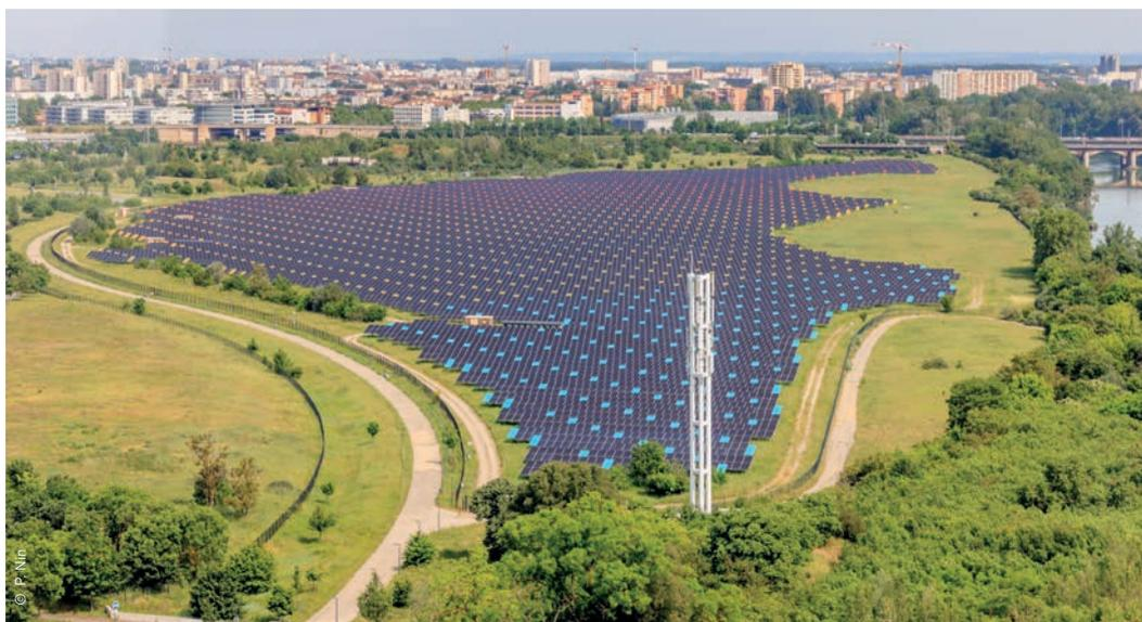
La centrale photovoltaïque implantée sur le site de l'Oncopole compte 35 000 panneaux solaires installés sur des terrains de l'ancienne usine AZF. Cette opération participe à la reconversion d'une partie du site ainsi qu'à la démarche métropolitaine en matière de transition énergétique. Cette centrale au sol peut assurer la fourniture d'une consommation électrique de 4 100 foyers.
