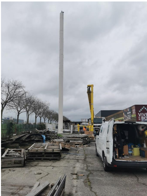
Photographies après travaux
