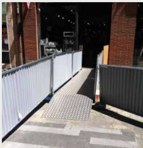
Pont piéton métallique
