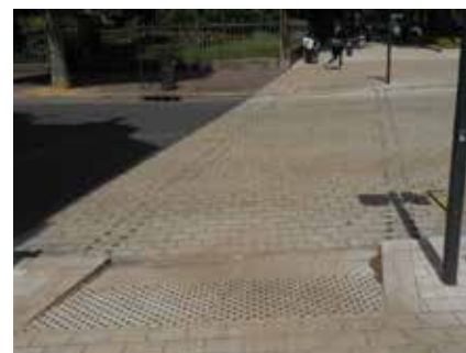
Délimitation de passage piéton large en dallage avec clous-Toulouse
