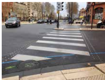
Délimitation de passage piéton large Toulouse
