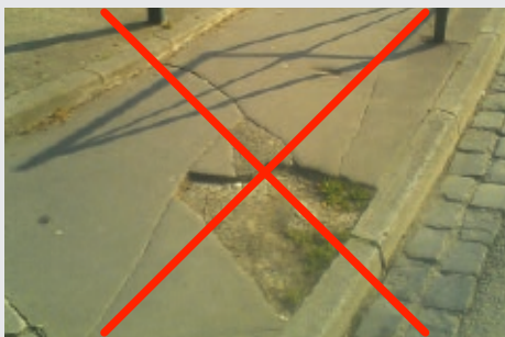
Défaut de revêtement - Toulouse
