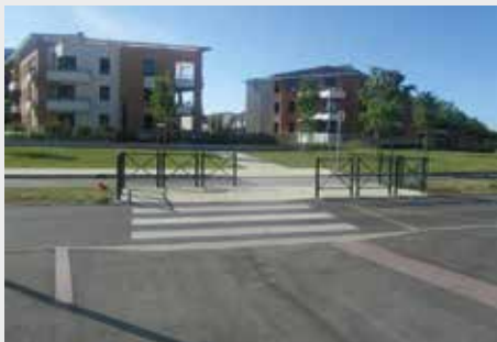
Îlot refuge en baïonnette - Colomiers
