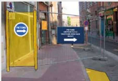
Travaux sur trottoir sans itinéraire accessible - Toulouse
