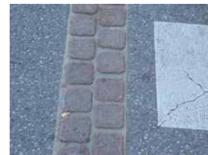
Détail des pavés de délimitation des passages piétons Toulouse Métropole.
