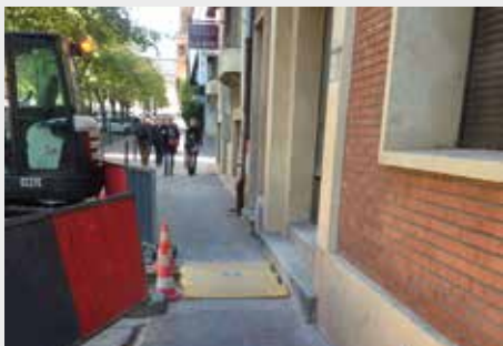
Pont piéton en plastique - Toulouse Métropole
