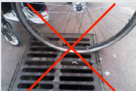
Grille non conforme bloquant les roues de fauteuil roulant - Toulouse
