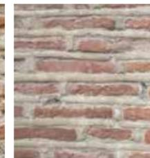
Joint de finition bombé\*, saillant (coloration avec sable, texture grains fins).
