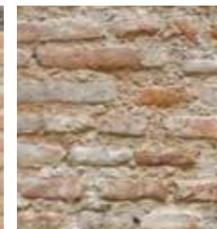
Joint de hourdage en creux coloration avec sable et riblon, texture à gros grains.
