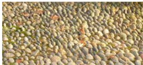
traitement de sol fini, en extérieur ou en intérieur, mettant en œuvre des pierres ou des galets bruts et posés de chant (de profil). Les galets ou pierres sont généralement posés sur une couche meuble de terre, de sable ou de mortier de chaux naturelle.
