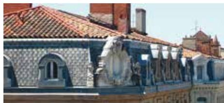
pan inférieur d'un versant de comble à la Mansart situé sous la ligne de bris. Le bris désigne la ligne de changement de pente entre deux pans d'un même versant de comble.
