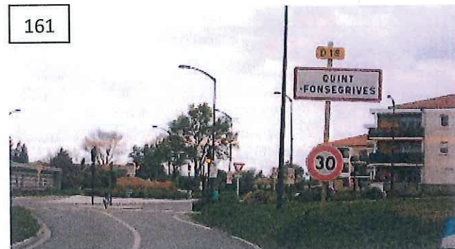
Route de la Saune (RD 18) en direction du Centre-ville (Début d'agglomération)
