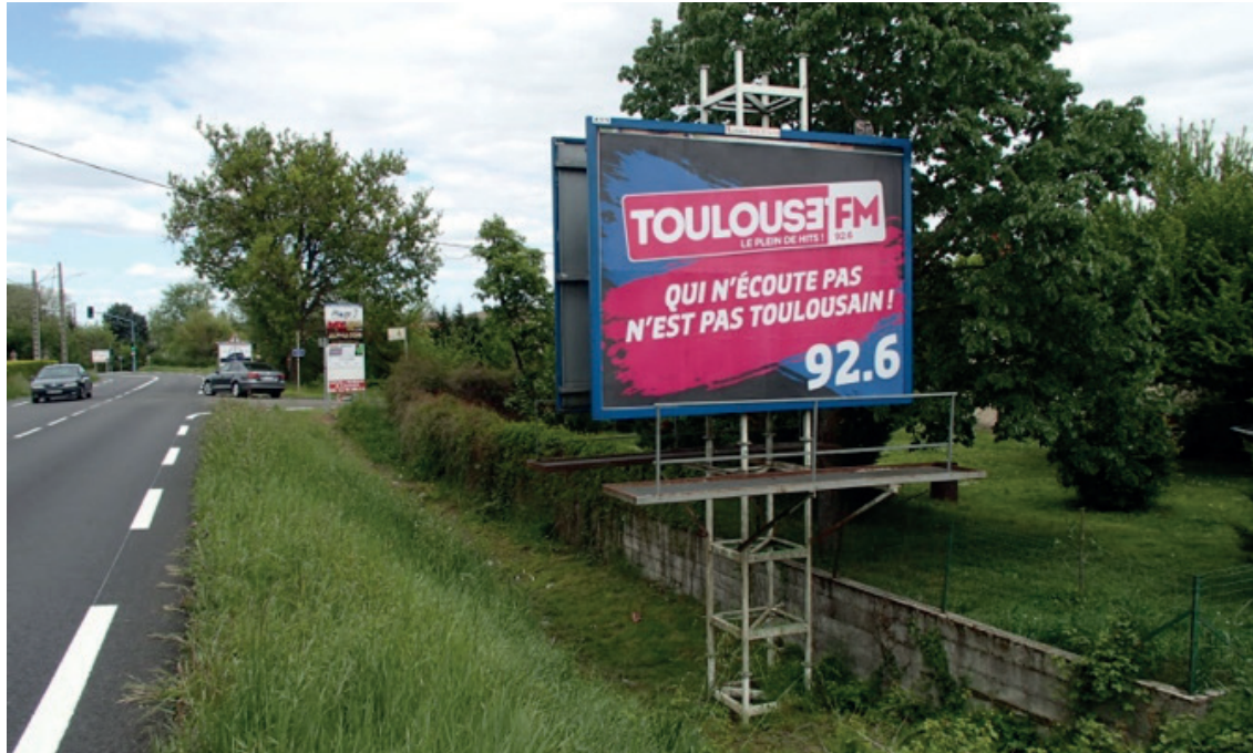
Pied « tour Eiffel » avec passerelles visibles
