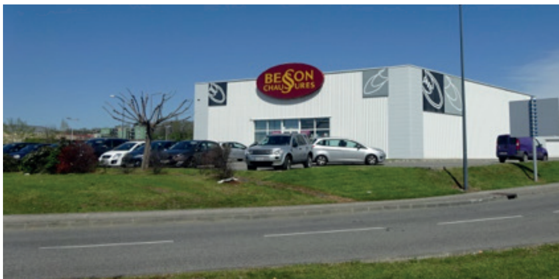
Enseigne dépassant du mur
