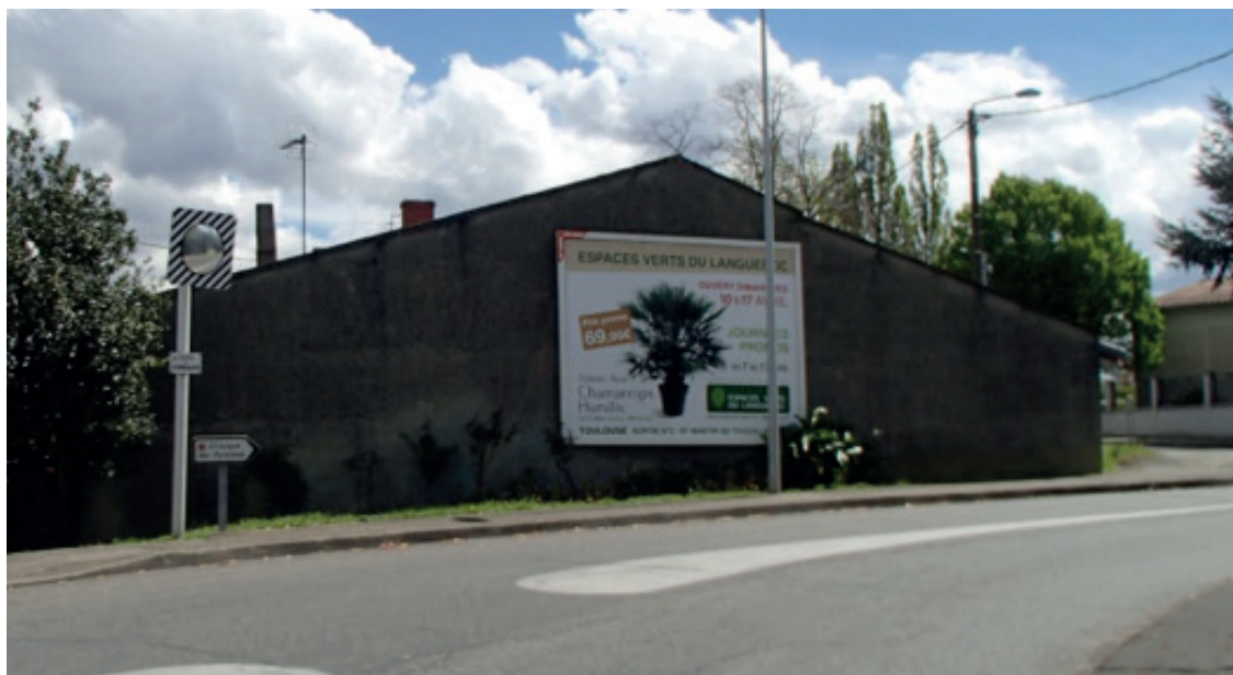
Dispositif mural illégal car dépassant l'égout du toit
