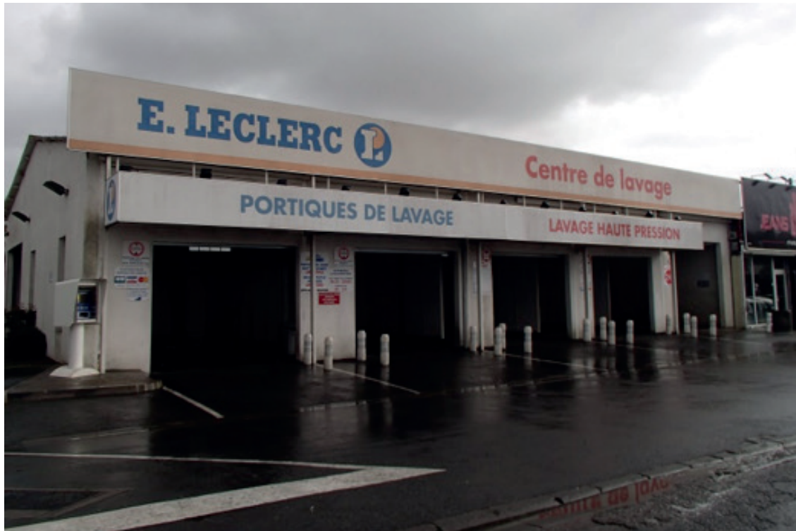
Enseigne illégale dépassant le mur-support
