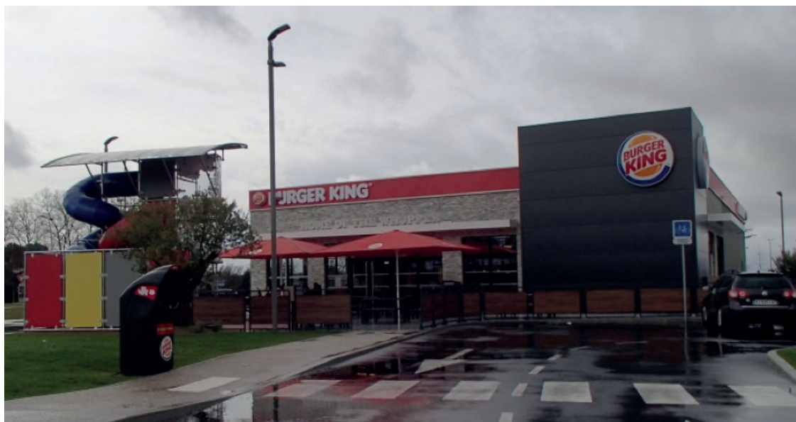
Enseigne respectant la proportion surface enseigne/surface façade
