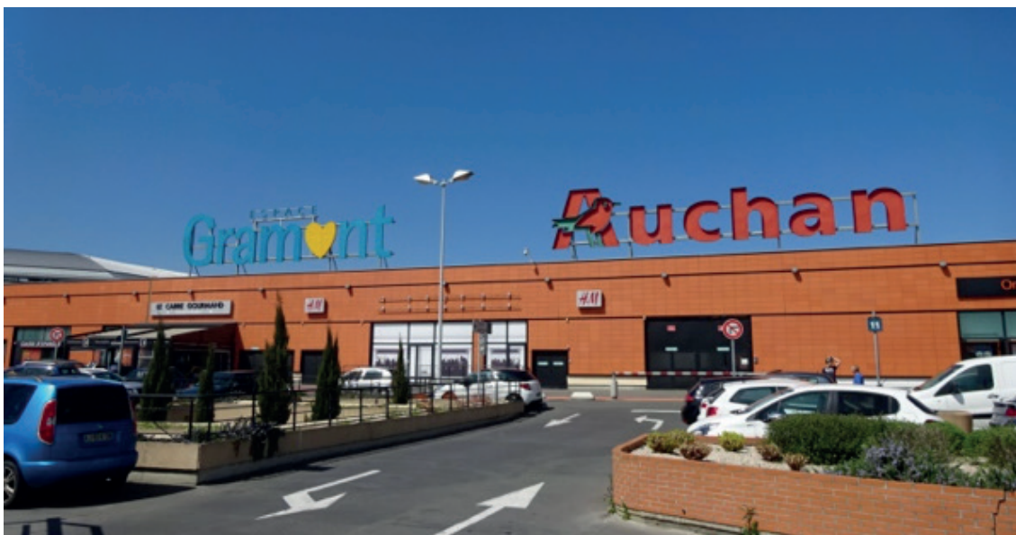
Enseignes en toiture dont les structures sont presque invisibles
