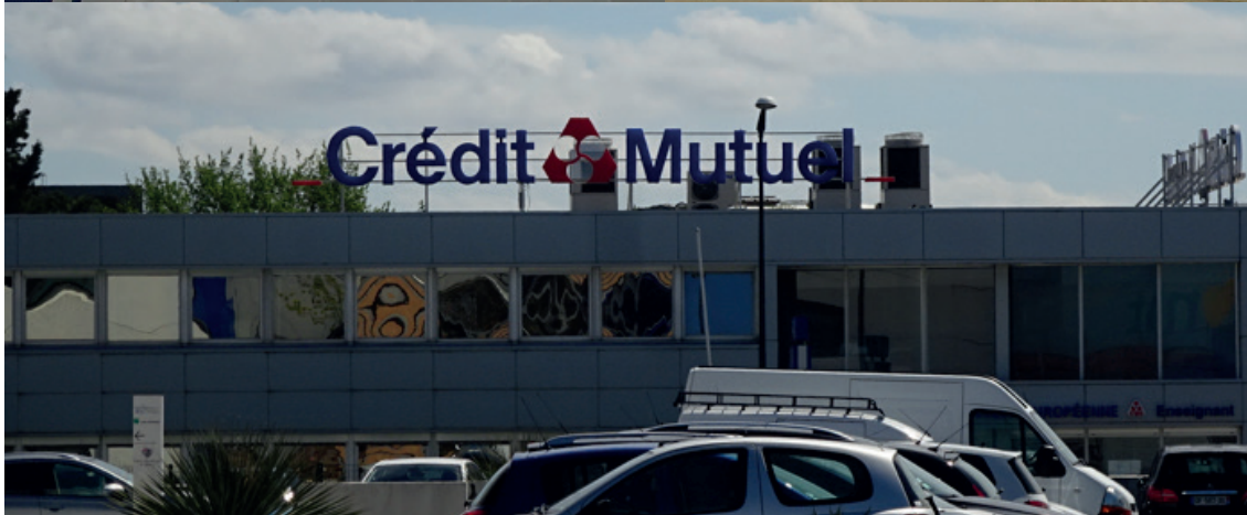
Enseigne en toiture dont les structures sont apparentes
