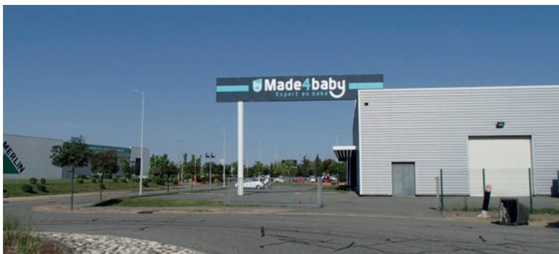
Enseigne scellée au sol (en partie) illégale
