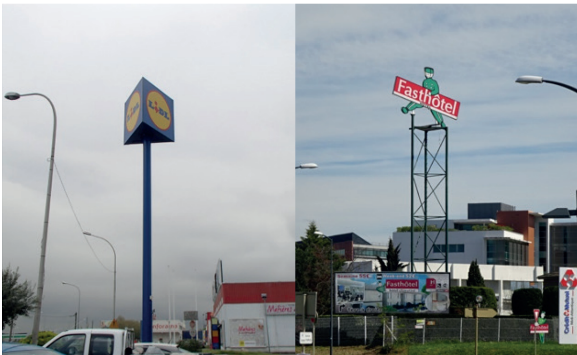
Enseignes scellées au sol illégales (hauteur supérieure à 6,50 m)
