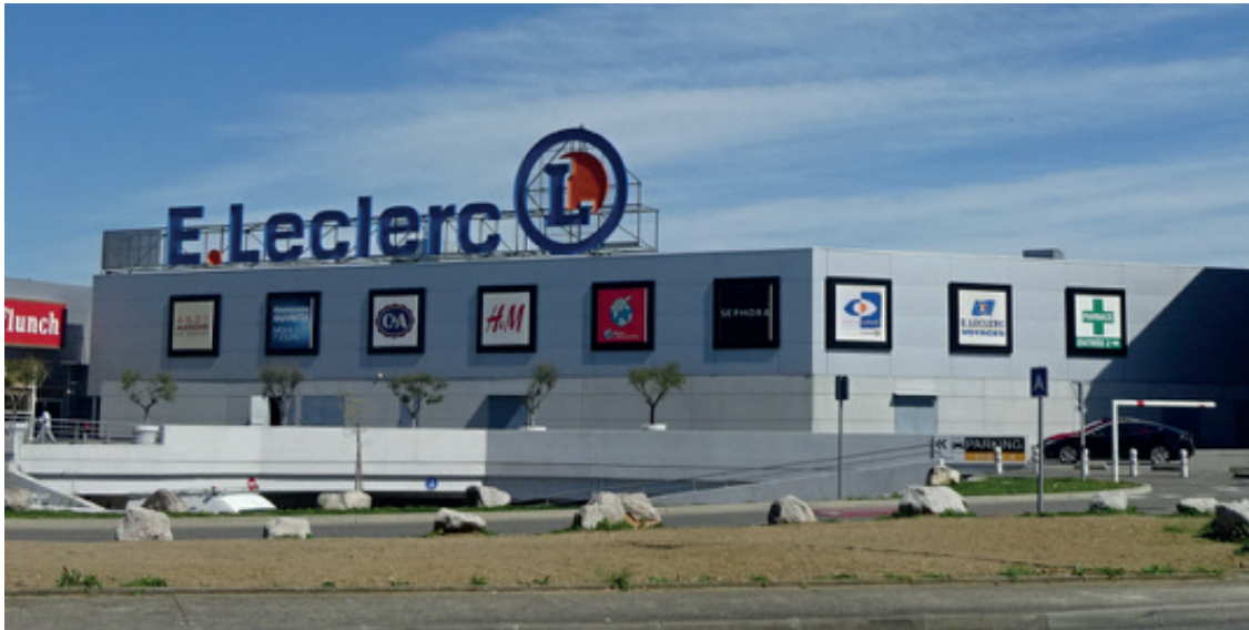
Enseigne en toiture
