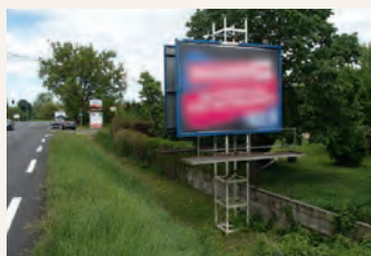
Pied «tour Eiffel» avec passerelles visibles.
