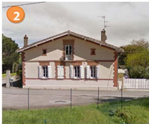
Rue de la Pépinière
