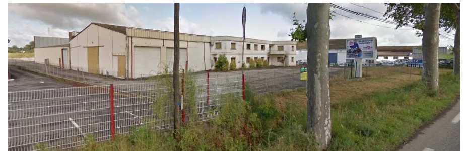
Exemple de bâtiments déqualifiés le long de la RD 820
