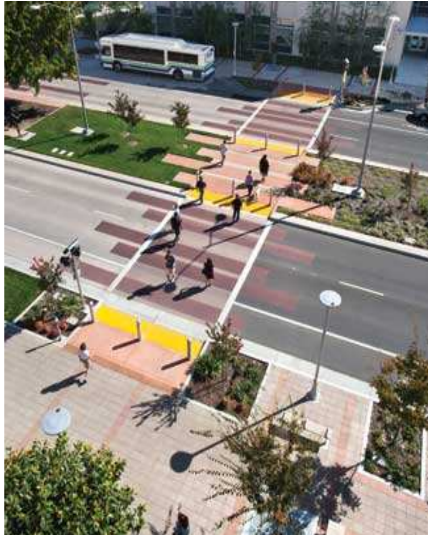
West Capital Boulevard à Sacramento (USA) : référence de traversée piétonne sécurisée et qualitative sur un axe structurant
