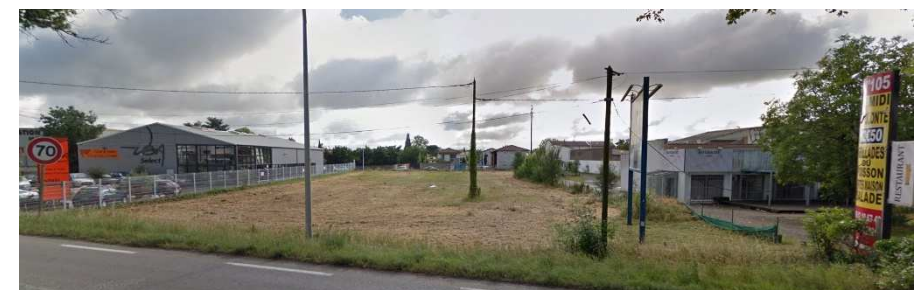
Exemple de friche d'activités le long de la RD 820
