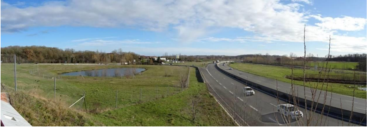
La RN 124, son bassin d'orage dans l'échangeur de Pibrac
