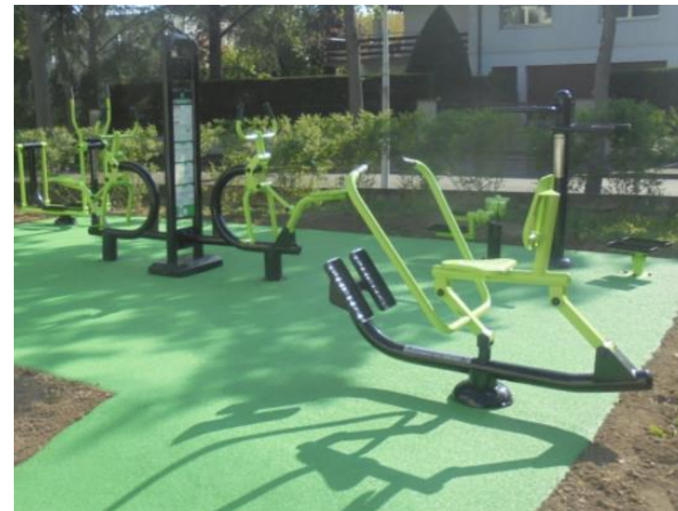
Création d'une aire de modules fitness
