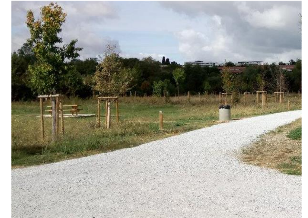
Réfection du cheminement autour du lac en grave 0/20
