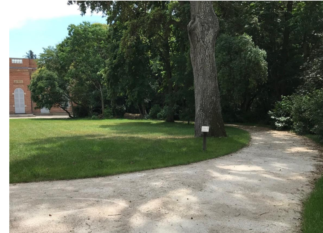
Réfection des allées secondaires en stabilisé
