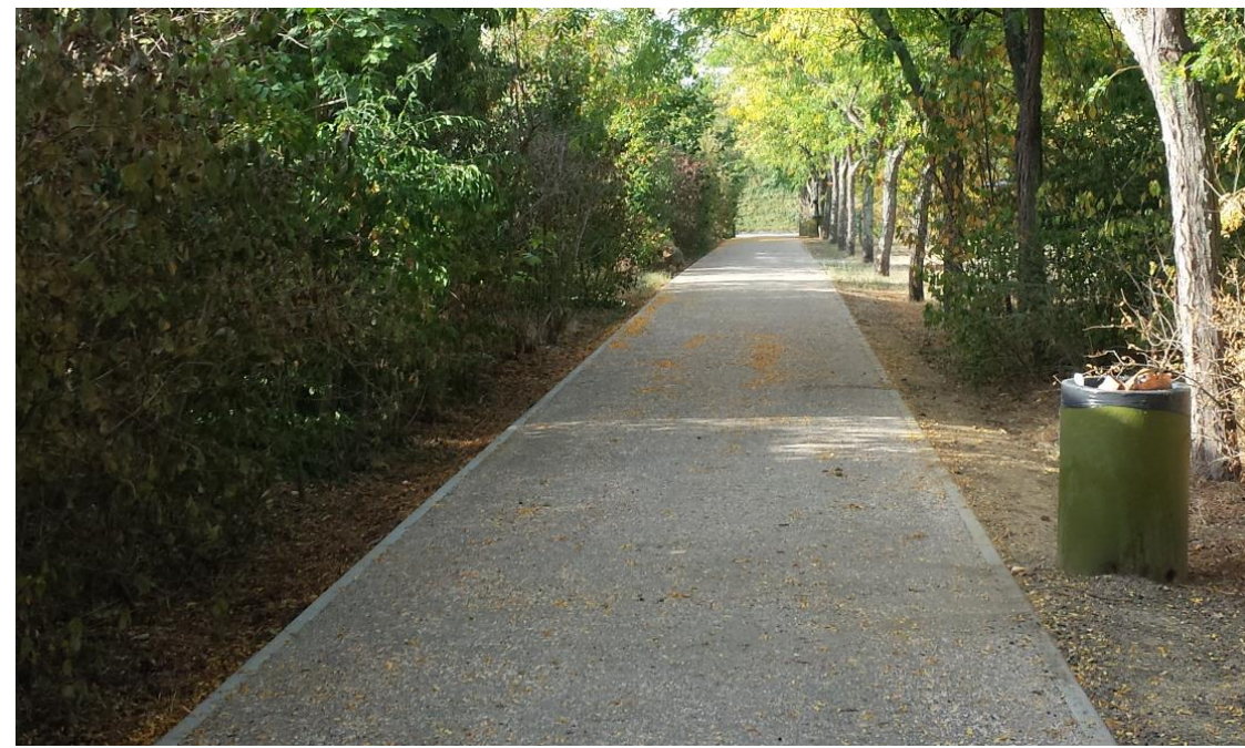
Réfection des allées en grave émulsion calcaire
