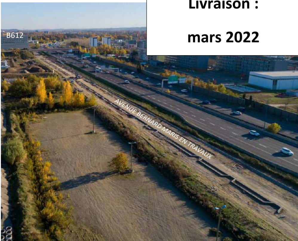
Tronçon en travaux
