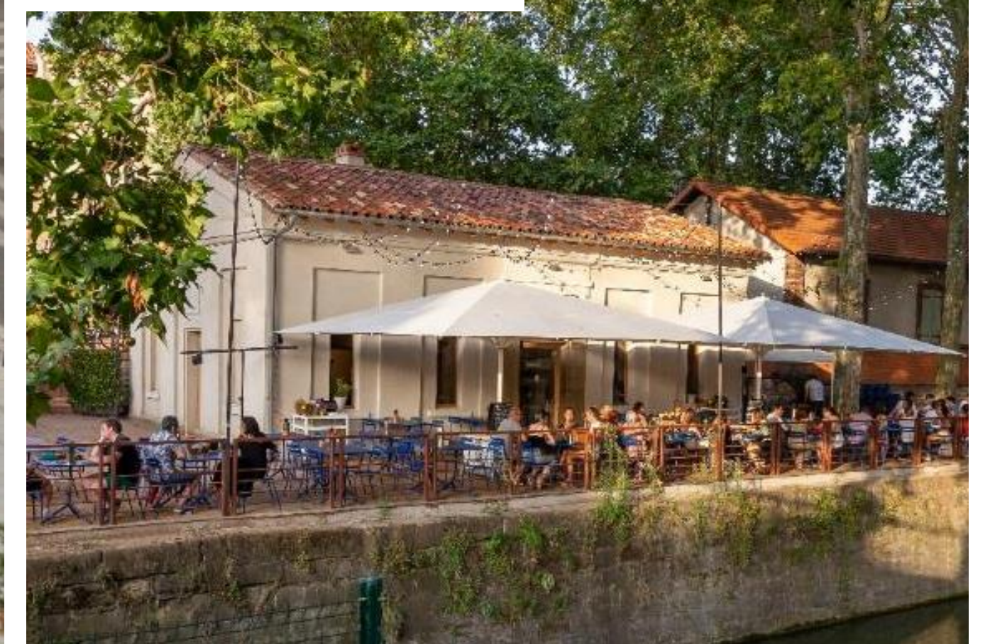
La maison éclusière
