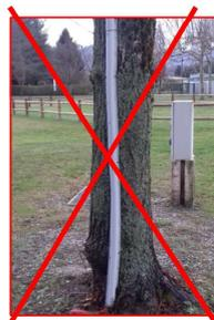
Goulotte passe-câble vissée sur le tronc d'un tilleul.
