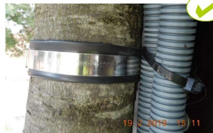
La sangle métallique n'est pas au contact du tronc, elle est apposée sur une bande en caoutchouc.
