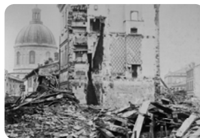
› Crue de 1875 : 209 victimes, 1 140 maisons détruites et 25 000 sans-abri (sur la photo, rue du Pont Saint-Pierre)
